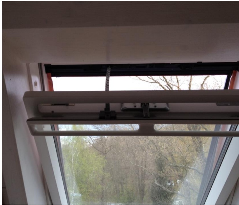
Obr. 4.6 Detail ovládání střešního okna pomocí motoru
