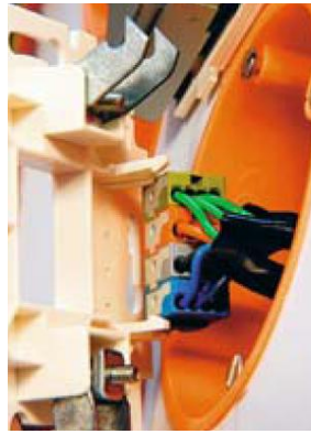
Obr. 2.1 Detail zapojení zásuvky pomocí sběrnového kabelu
