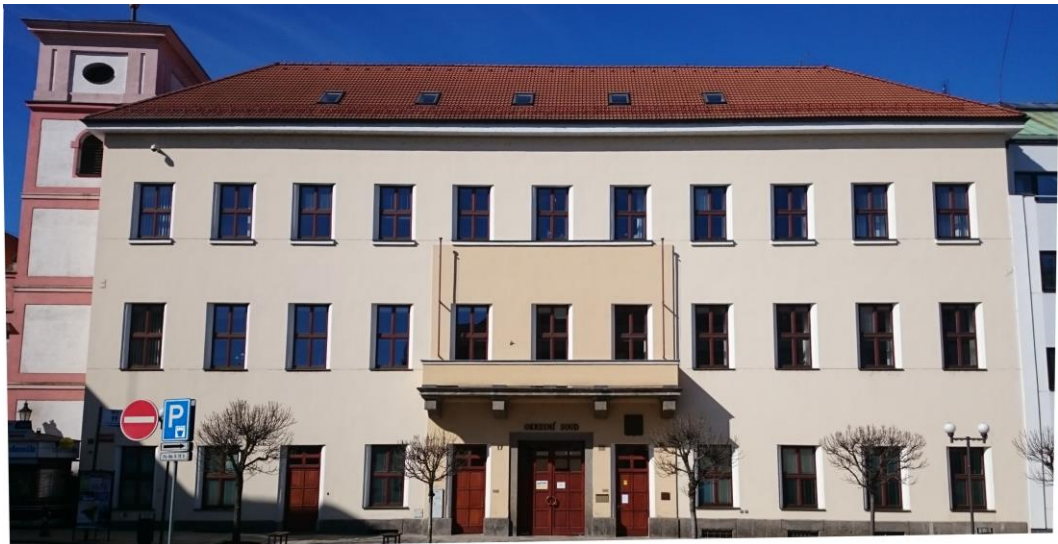
Obrázek 2 (foto autor): Nová budova Okresního soudu v Písku
