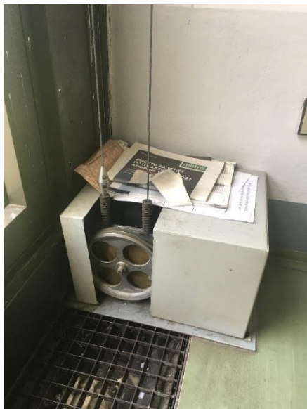
Obr. č. 21 - Mechanismus pro pohon závěsů
