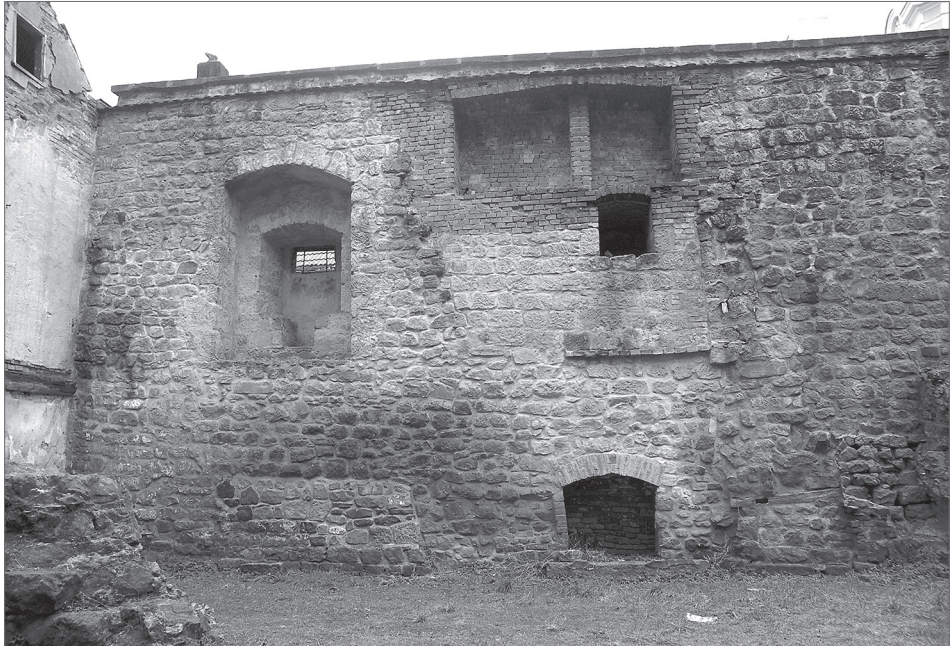
Obr. 7. Severní obvodová zeď severního křídla hradního jádra po zbourání stavby. Foto L. Kursová.
