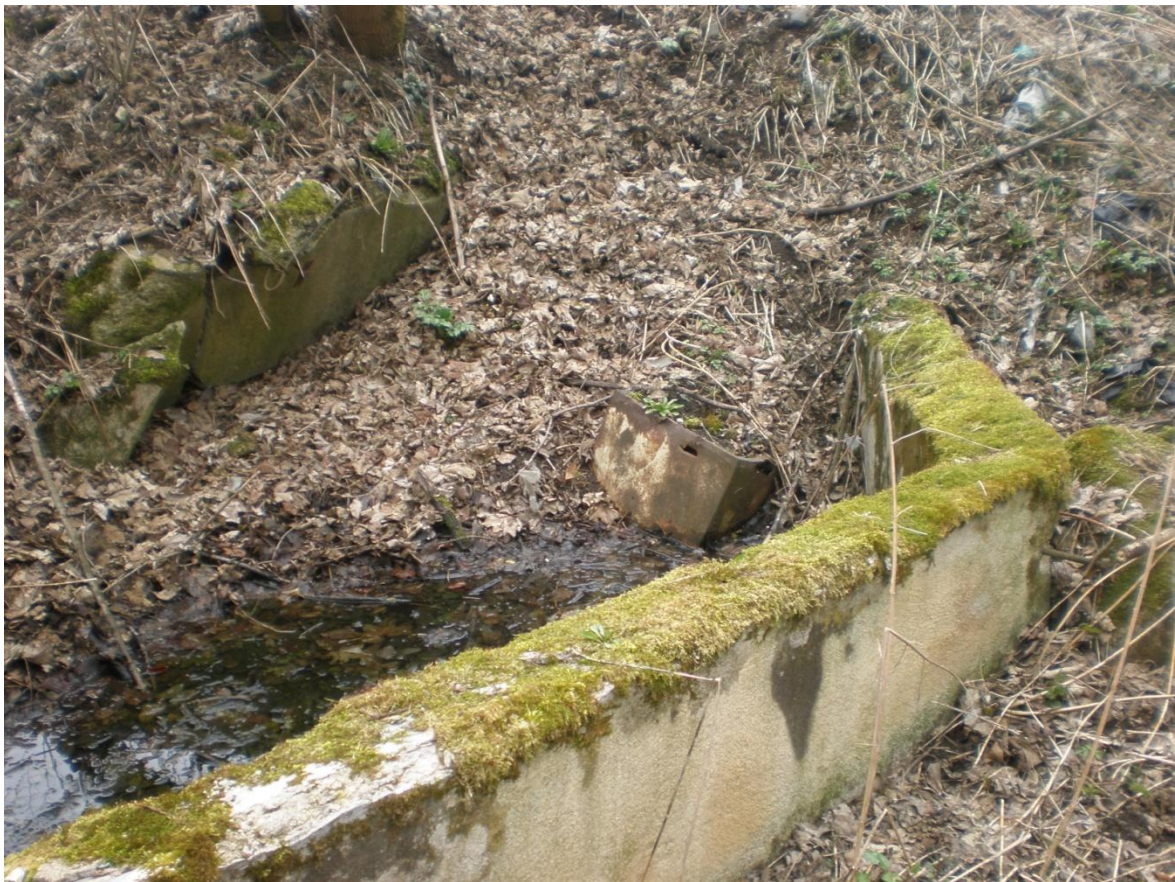
Nádrž na vodu (098); Foto č. 22
