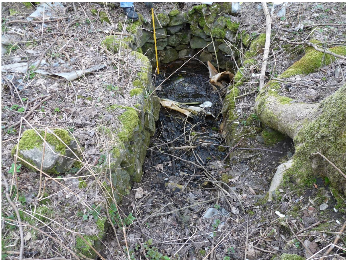
Kruhový objekt (GPS 087 a 088), oba objekty vypadají stejně; Foto č. 4
