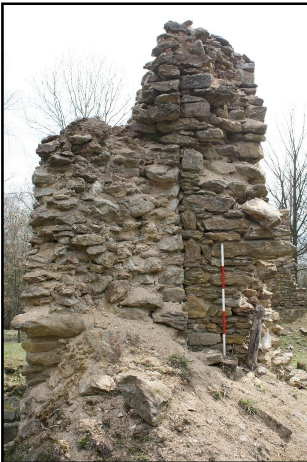
Obr. 21 – Spára mezi severní a východní zdi lodi – foto autor
