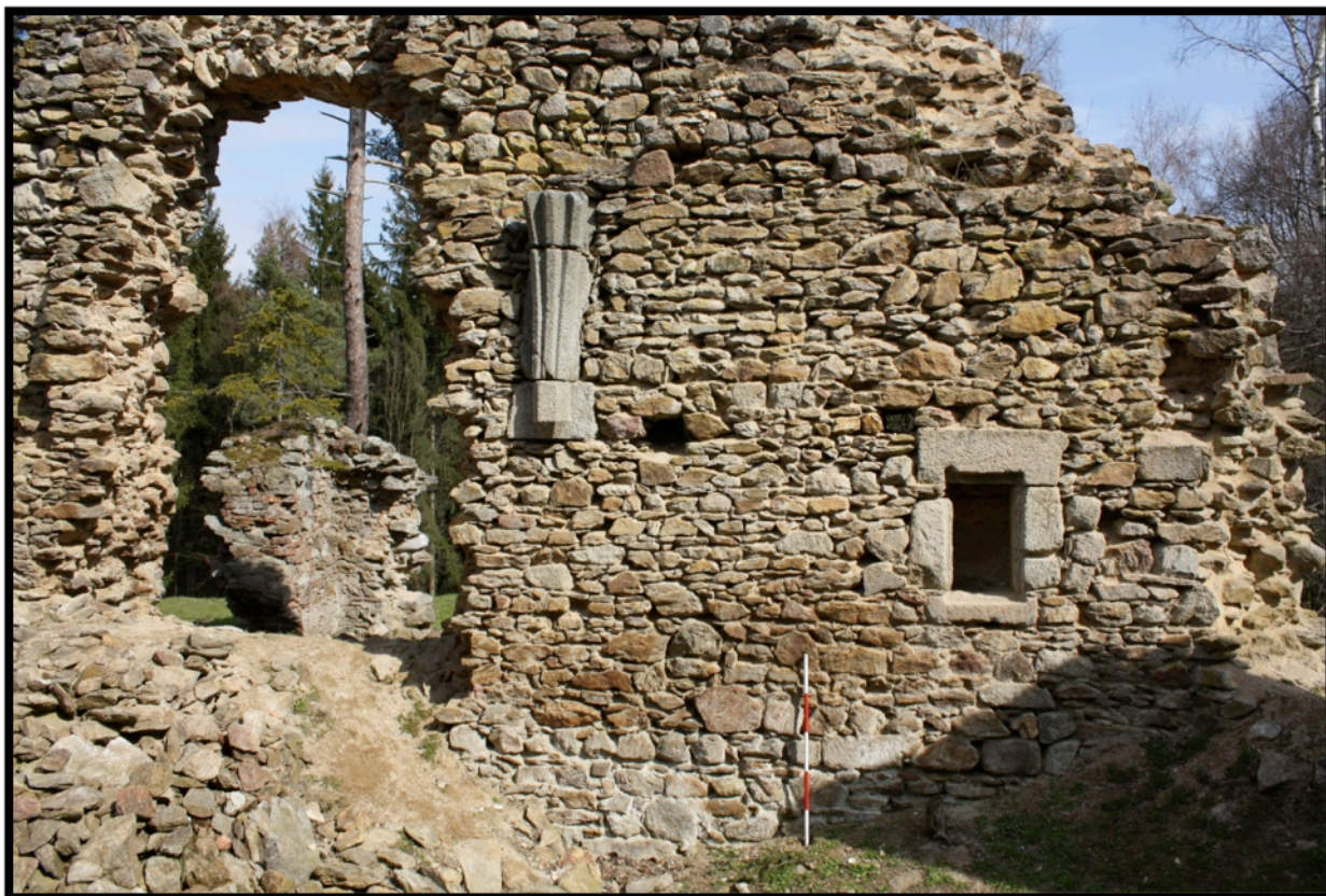
Obr. 22 – Evangelijsní strana presbyteria – foto Bauer
