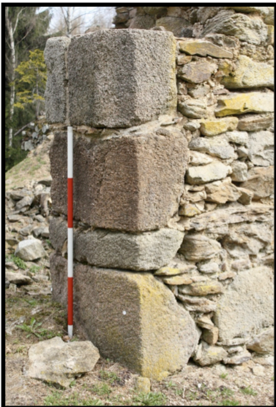
Obr. 19 – Obložení vstupního portálu - autor
