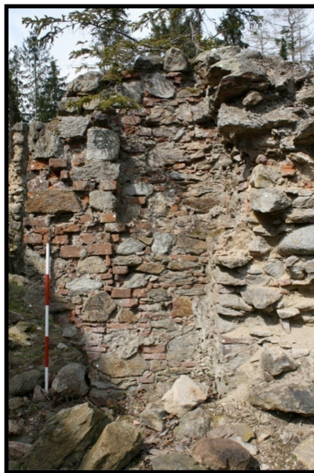
Obr. 31 – Skladba zdiva sakristie – foto Bauer
