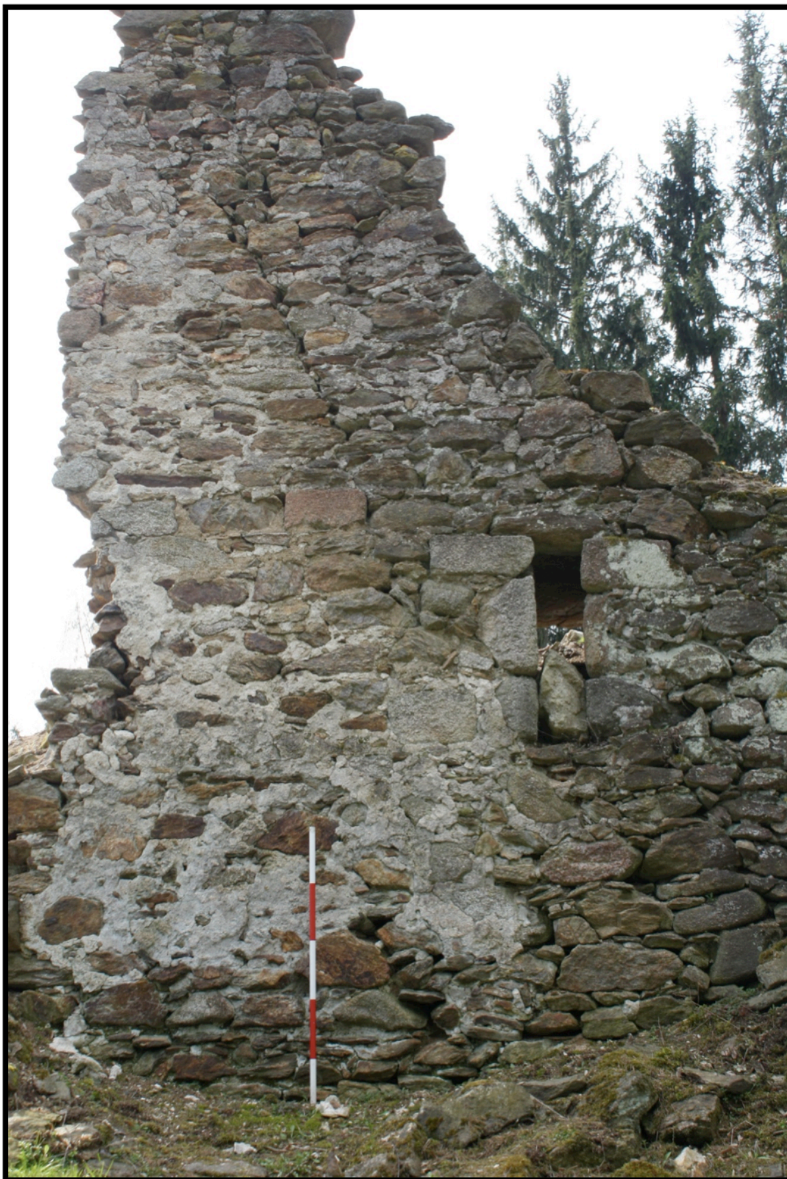
Obr. 28 – Torso západní věže, pohled od severu (na jižní straně zdivo evokuje spáru, paty je však provázáno) – foto autor
