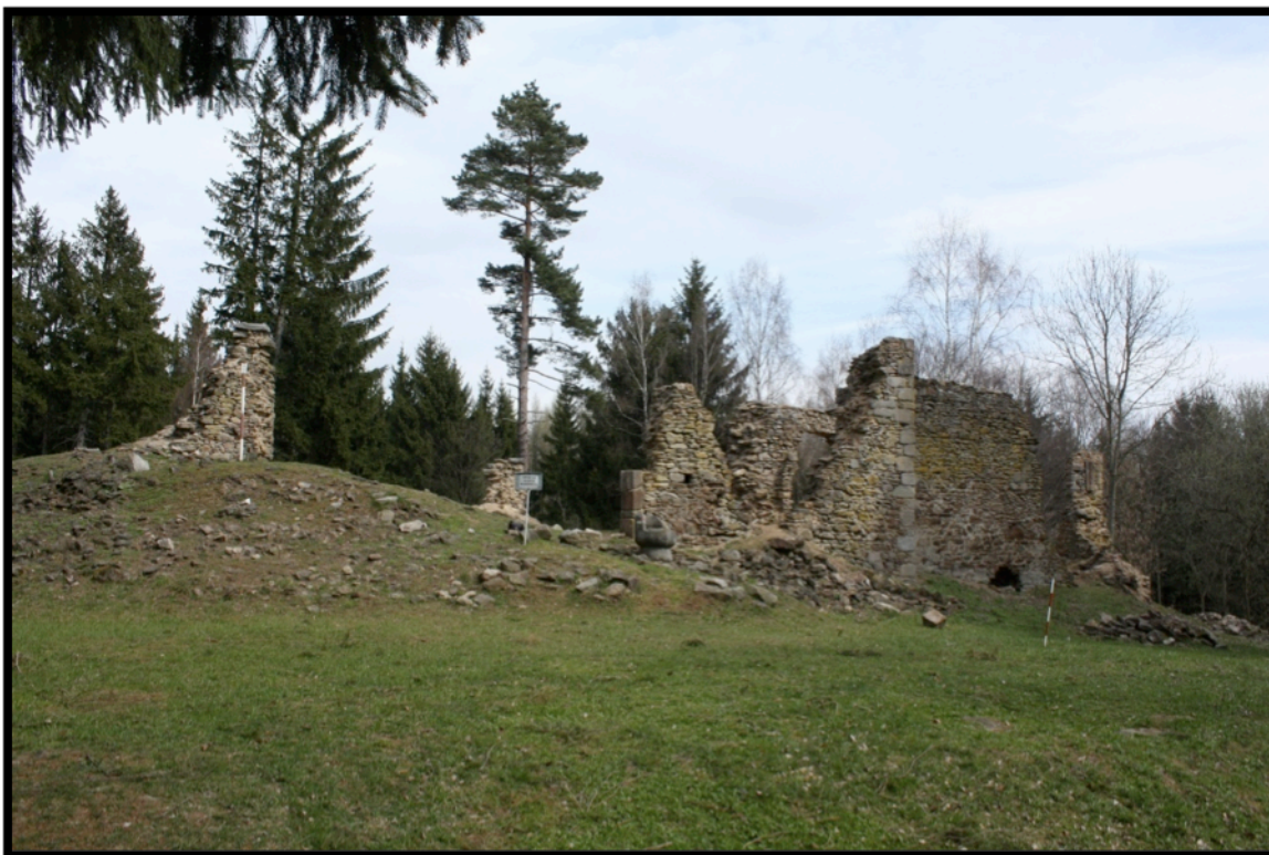
Obr. 18 – Celkový pohled od jihu 2012 – foto autor
