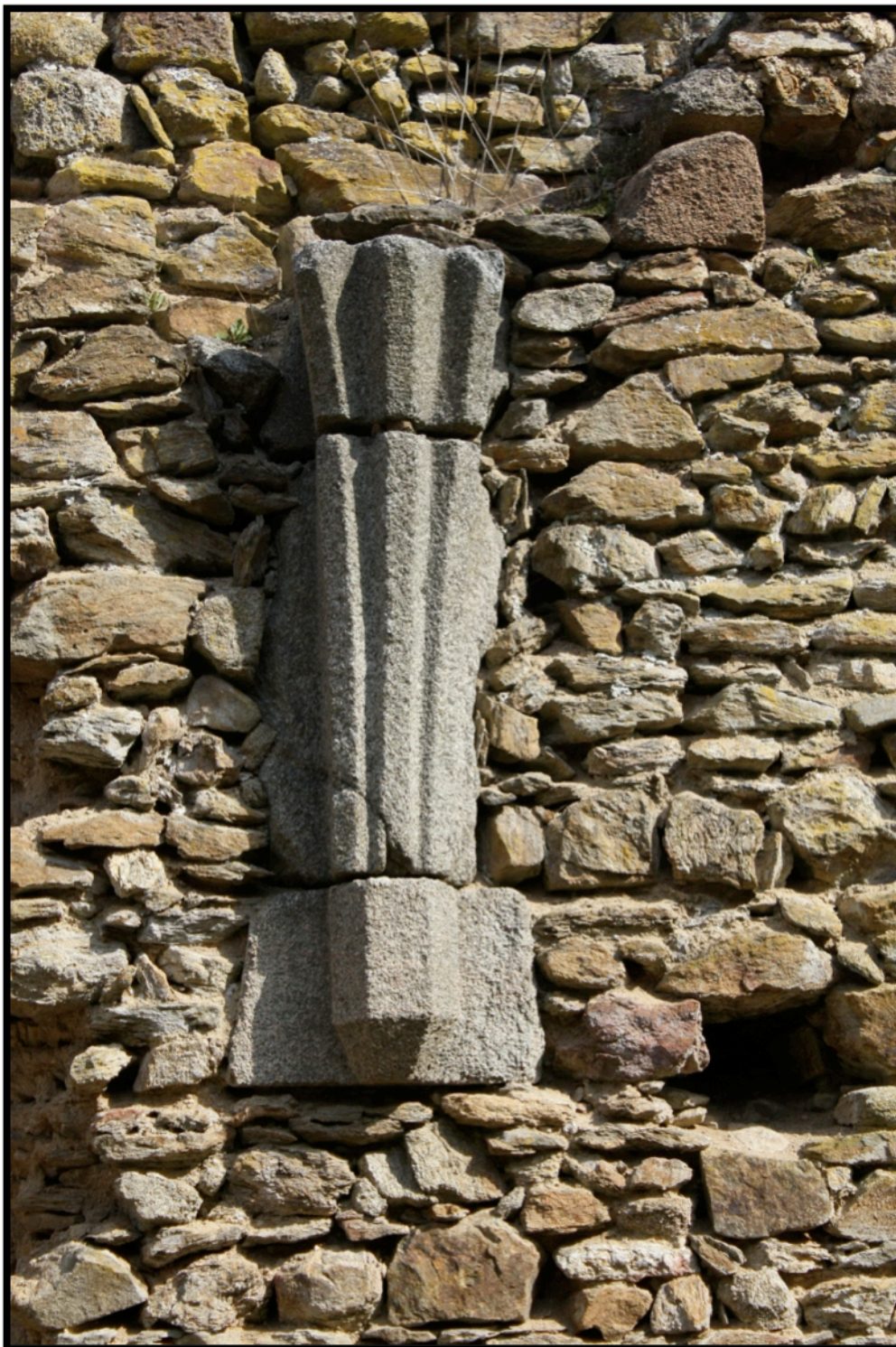
Obr. 24 – Klenební konsola s náběhy žeber – severní stěna presbyteria – foto autor
