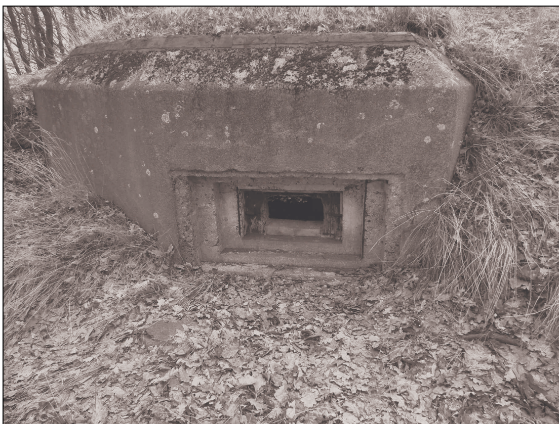
Obr. 1 a 2. Lehké opevnění vz.36 (čelní strana a detail na střelnu objektu). Foto S. Bednář.
