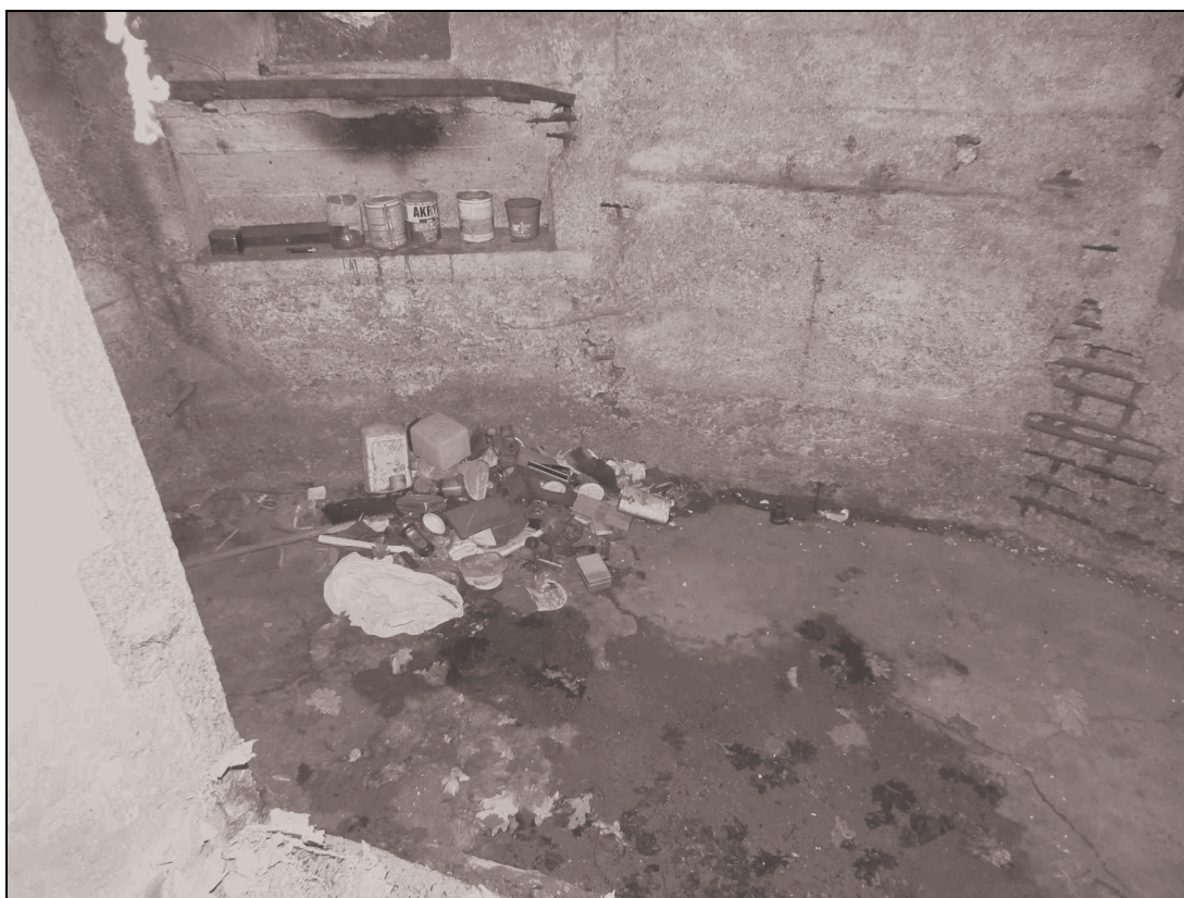
Obr. 11 a 12. Objekt V.a/19/B. Detail na odkopáný vstup do objektu a vnitřní „skladovací“ prostor. Foto S. Bednář.
