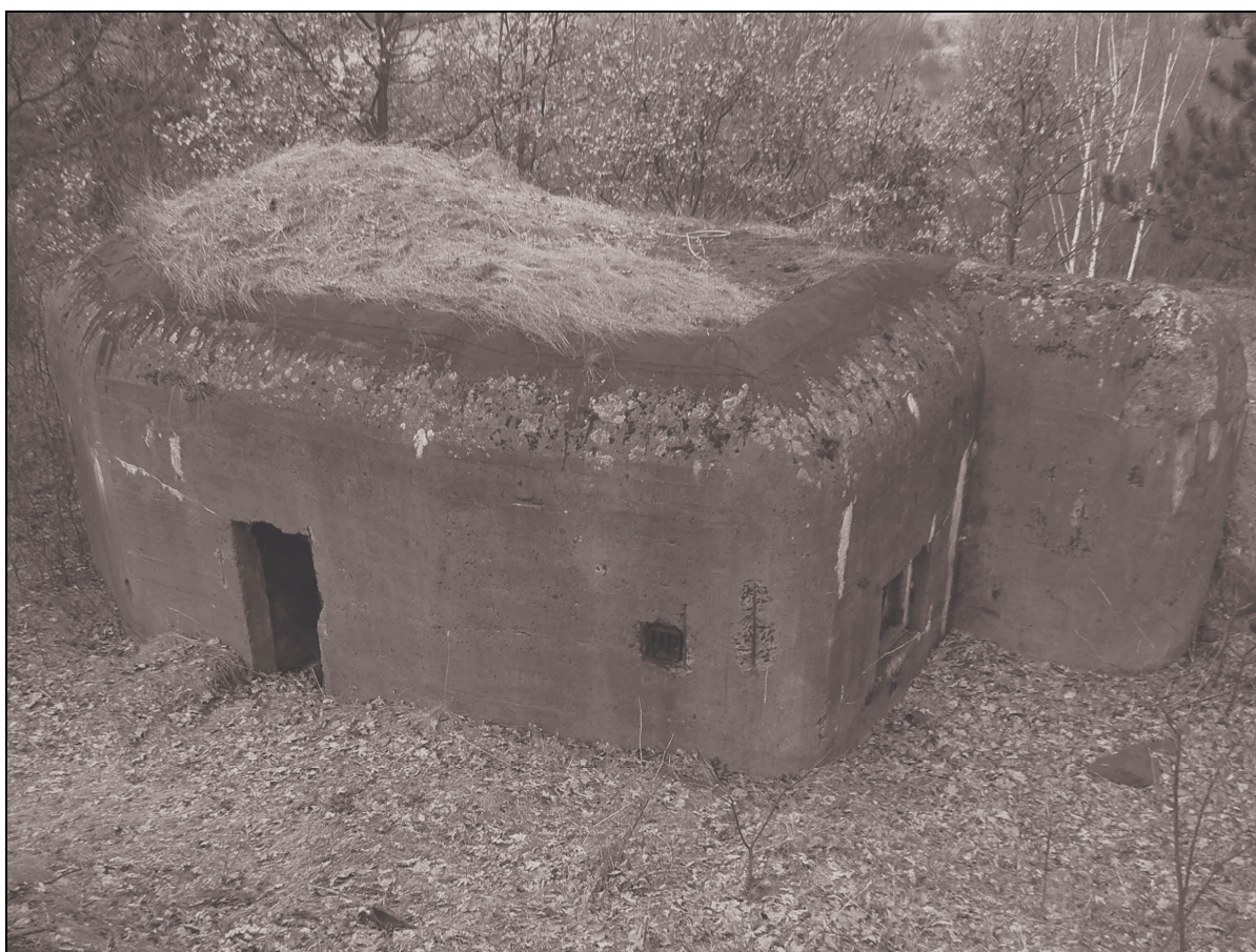
Obr. 5 a 6. Lehké opevnění vz.37 (boční střílna a týlová strana objektu) Foto S. Bednář.
