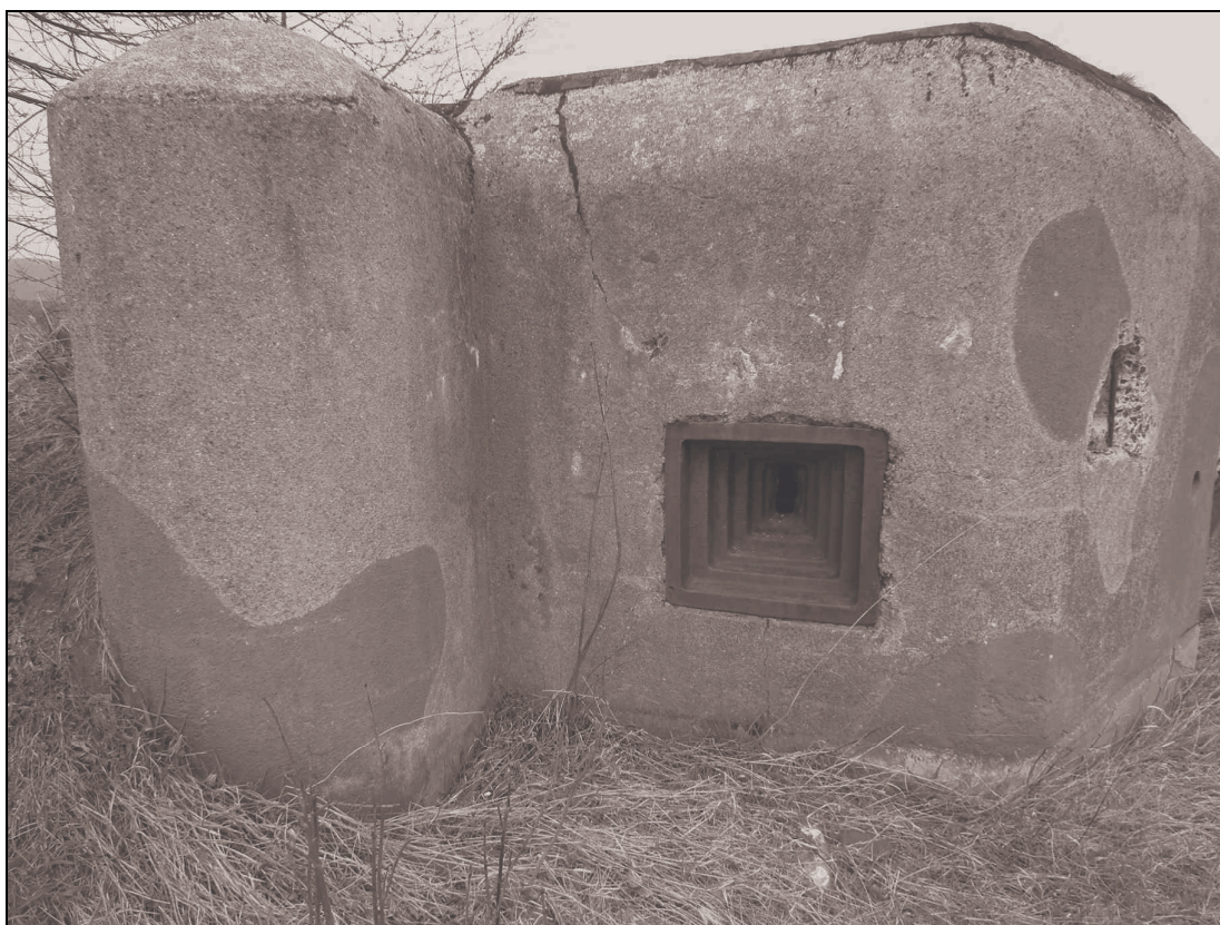
Obr. 15. K-50/1/D1 (detail původních pancéřových dveří). Obr. 16. K-50/2/A-160. Foto S. Bednář.
