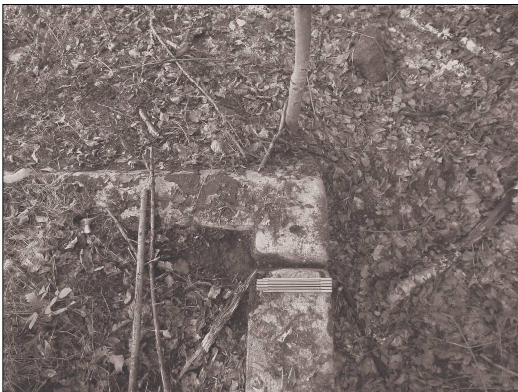
Obr. 3 a 4. Detail drenáže. Foto S. Bednář.
