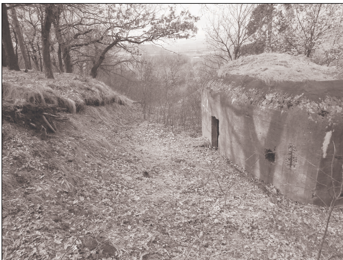
Obr. 19. Spojovací okop. Obr. 20. Pevnůstka vložená do odkopaného svahu. Foto S. Bednář.
