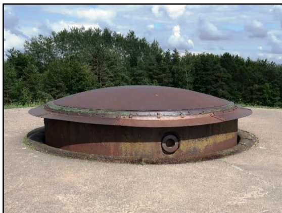
Obr. 1: Otočná a výsuvná věž T155R fortu Douaumont ve vysunuté poloze. (archiv autora, 2018)
