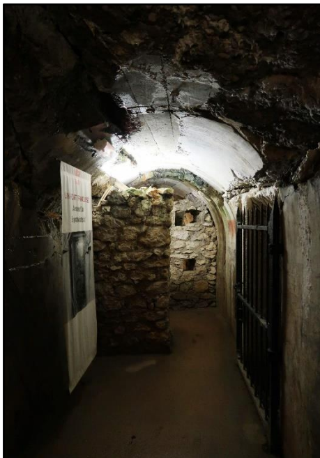
Obr. 11: Jedna z chodeb uvnitř fortu Vaux. Za povšimnutí stojí provizorní barikády vybudované v průběhu bitvy. (archiv autora, 2018)
