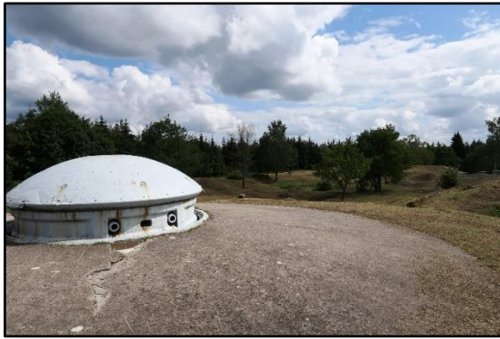
Obr. 7: Otočná a výsuvná věž T75 tvrže Froideterre ve vysunuté poloze. Věž vyzbrojená dvěma děly ráže 75 mm měla nemalý podíl na odražení německého útoku podniknutého proti tvrzi 23. června 1916. (archiv autora, 2018)
