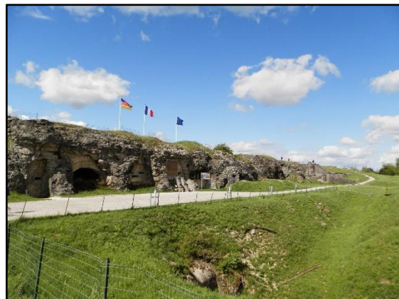
Obr. 2: Kasárenský objekt fortu Douaumont byl dělostřeleckým ostřelováním značně poškozen. Největší poškození způsobily francouzské houfnice ráže 400 mm. (archiv autora, 2017)
