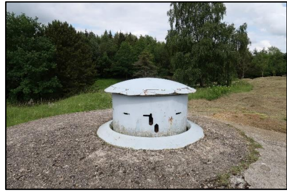
Obr. 8: Otočná a výsuvná kulometná věž GF4 ve vysunuté poloze na tvrzi Froideterre. (archiv autora, 2018)
