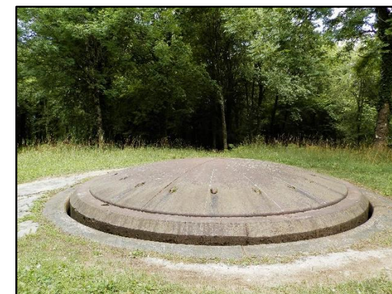
Obr. 6: Otočná a výsuvná věž Boussière v zasunuté poloze. Pancéřová věž tvořila výzbroj samostatné baterie umístěné v blízkosti fortu Souville. (archiv autora, 2017)
