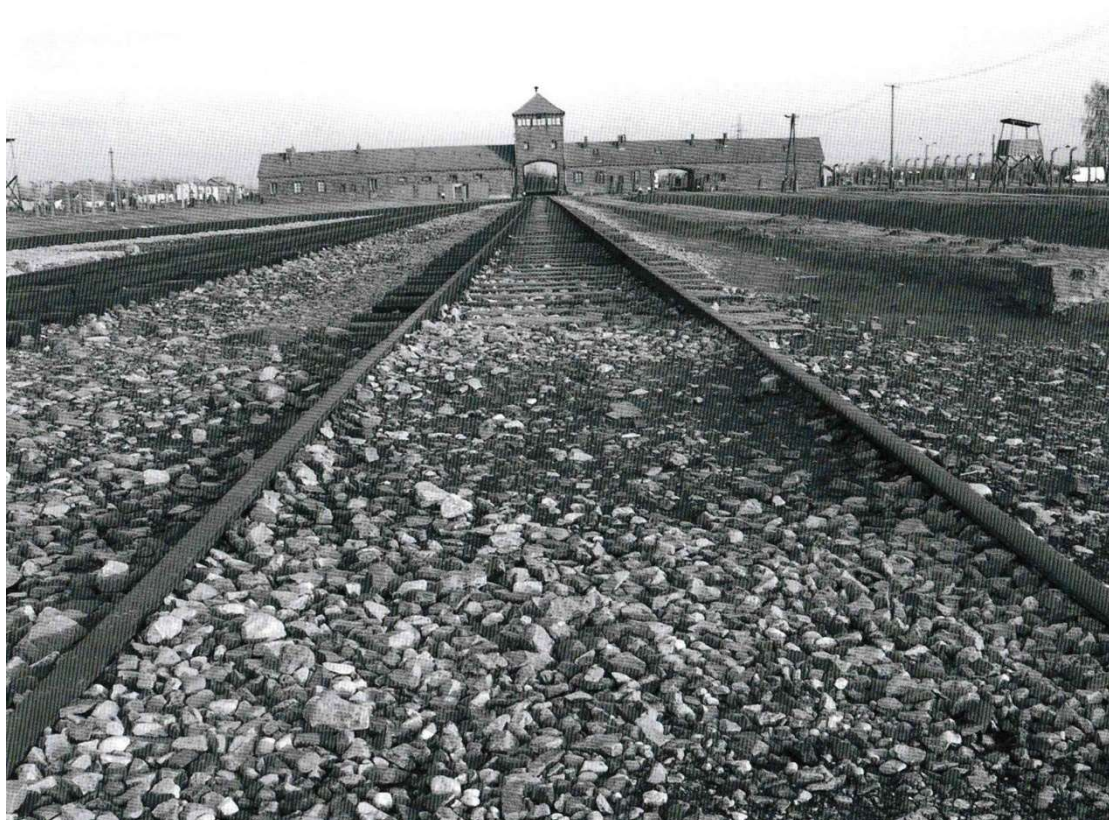
Příloha č. 3 – Snímek železniční tratě s hlavní bránou vedoucí do Březinky 154
