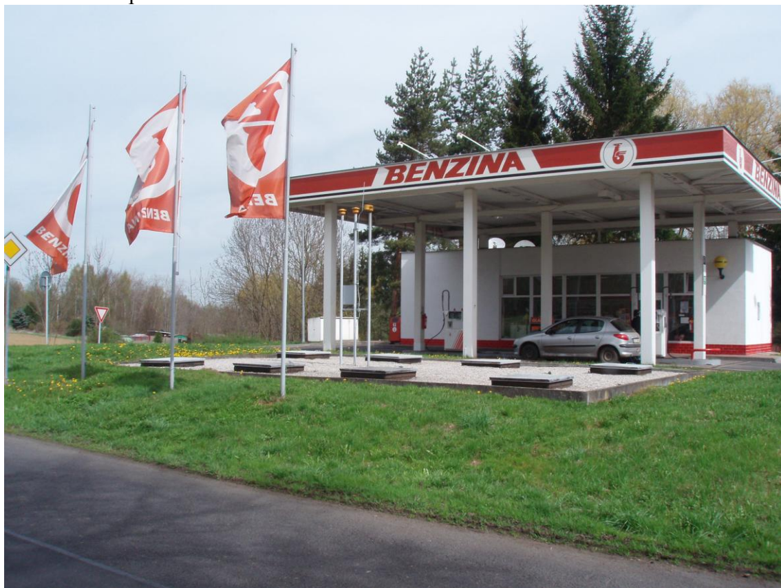
Obr. č. 2: Čerpací stanice Benzina-Toužim
