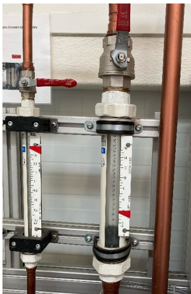
Obr. 38 Plovákový průtokoměr
