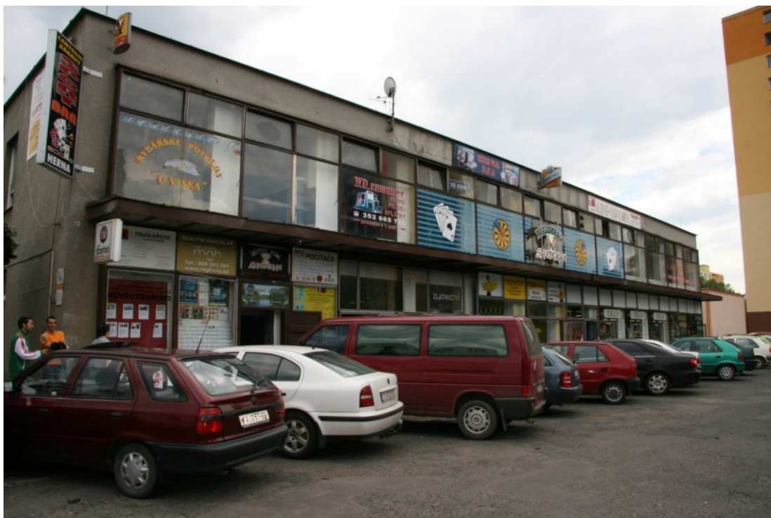
Příloha 4: Nemovitost po rekonstrukci – Chodov
