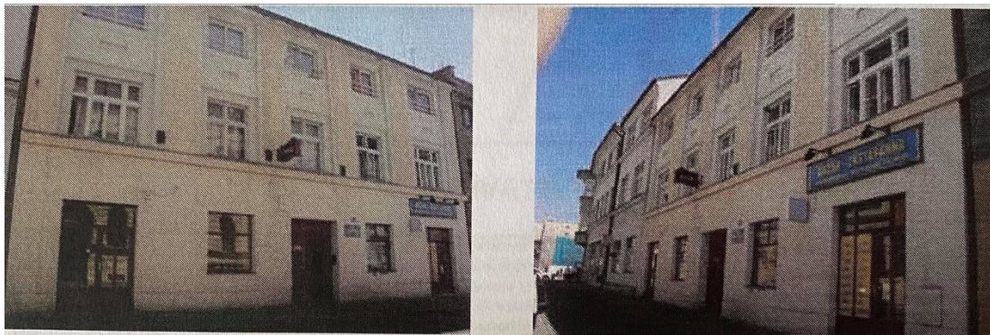
Příloha 6: Prodejny před rekonstrukcí
