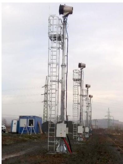
Obrázek 2: Rotační mlžící jednotka
