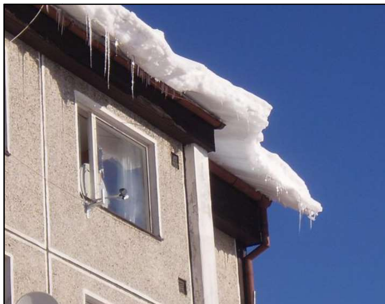
Obrázek 5 - Stavba v Krušných horách, bez přesahu střechy
