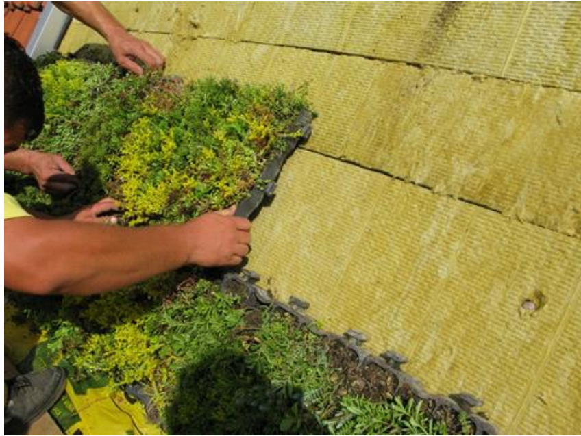
Obrázek 8 - Osazení vegetačních koberců na šikmou střechu [4]
