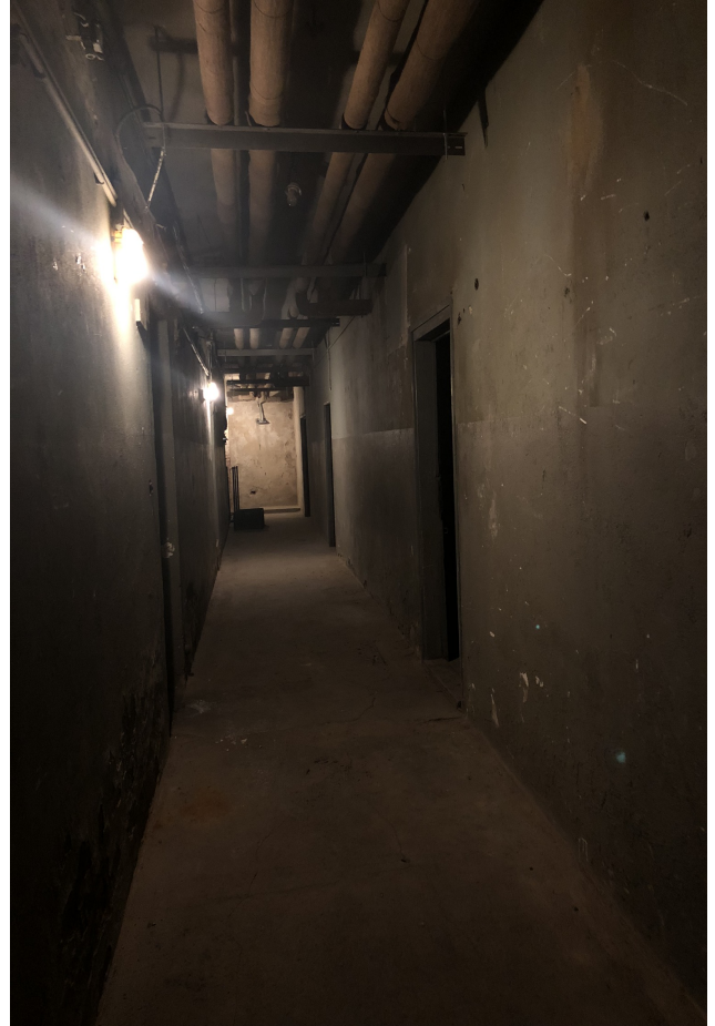
Sklep hlavní budovy zámku.
