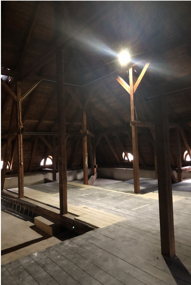
Půda hlavní budovy zámku.
