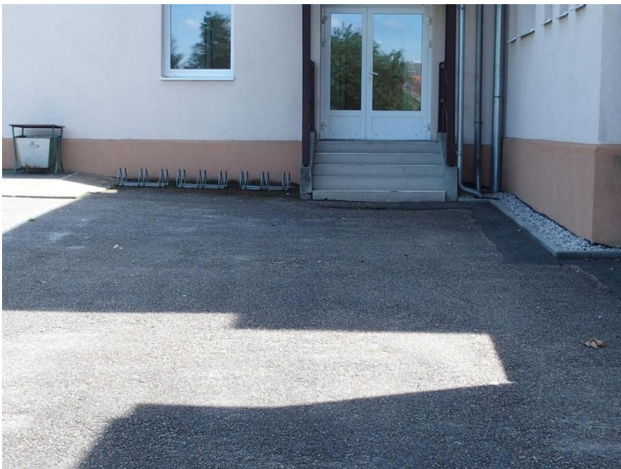
Obr. 20. Prostor pro umístění podzemních nádrží na dešťovou vodu. (vlastní snímek)
