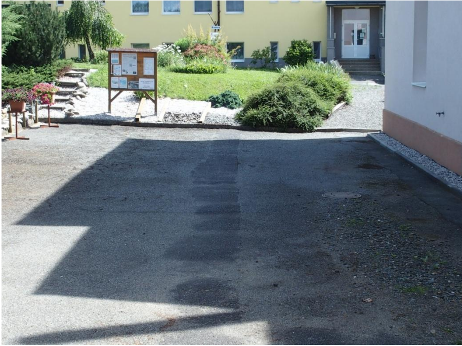
Obr. 19. Prostor pro umístění podzemních nádrží na dešťovou vodu. (vlastní snímek)
