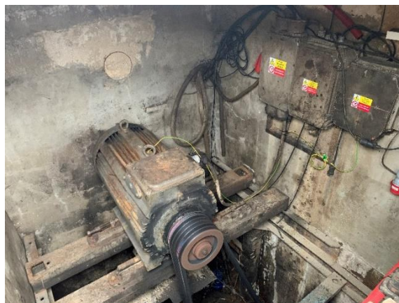
Obr. 3.9 Generátor MVE2
