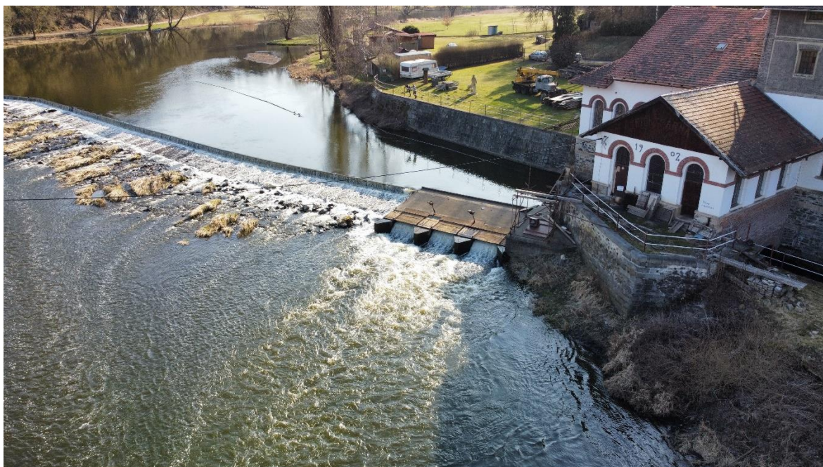
Obr. 1.5 Jezová vodní elektrárna v Nadrybech
