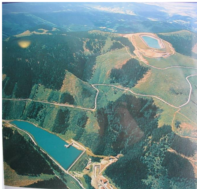
Obr. 1.7 Přečerpávací elektrárna Dlouhé Stráně Obrázek převzat z [6]
