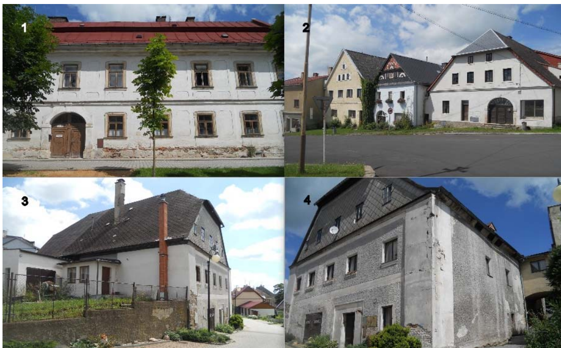
Obrázek č. 9 Město Teplá, 9.1. budova děkanského farního úřadu, 9.2. měšťanské domy, 9.3. mydlárna – boční pohled, 9.4. mydlárna – čelní pohled (Fotografie: Michaela Morávková, dne 7.7.2016)
