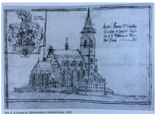
Obr. č. 8: Kostel sv. Bartoloměje a latinská škola, 1602
