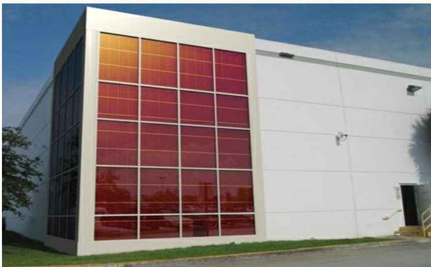
Obr. 10: Možnost použití průhledných panelů Power Plastic® převzato [11]
