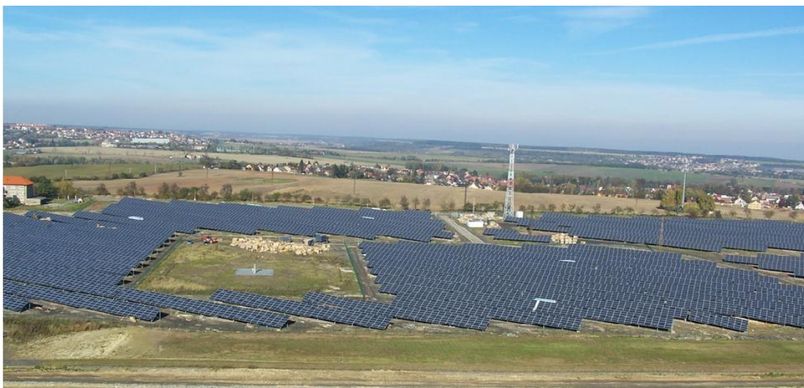
Obr. 16: Instalace fotovoltaického systému v lokalitě Tuchlovice-Dřevěnkov o instalovaném výkonu 7,8 MWp převzato [16]
