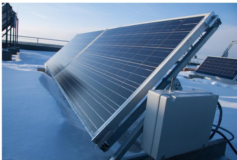
Obr. 11: Fotovoltaický panel s horizontálně polohovatelnou osou
