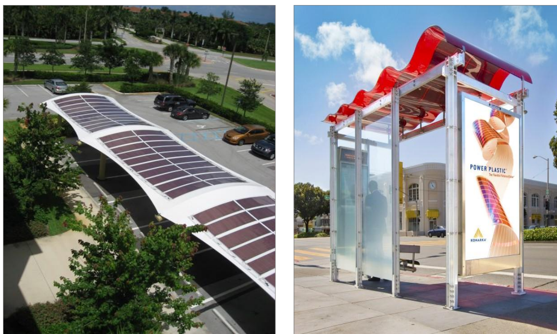
Obr. 2.4 Ukázka BIPV 1) vlevo parkoviště s přístřeškem poskytující přirozené chlazení 2) vpravo zastávka v San Franciscu s poskytující připojení na WI-FI. [33]
