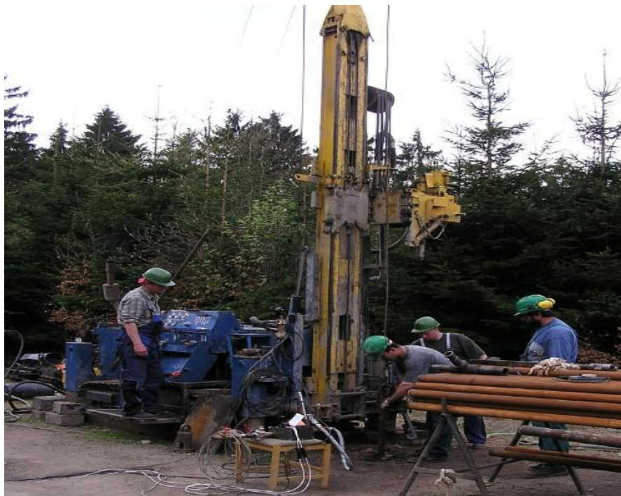
obr 3.8 Hloubení vrtu MEL-1 na testovací lokalitě Melechov [18]
