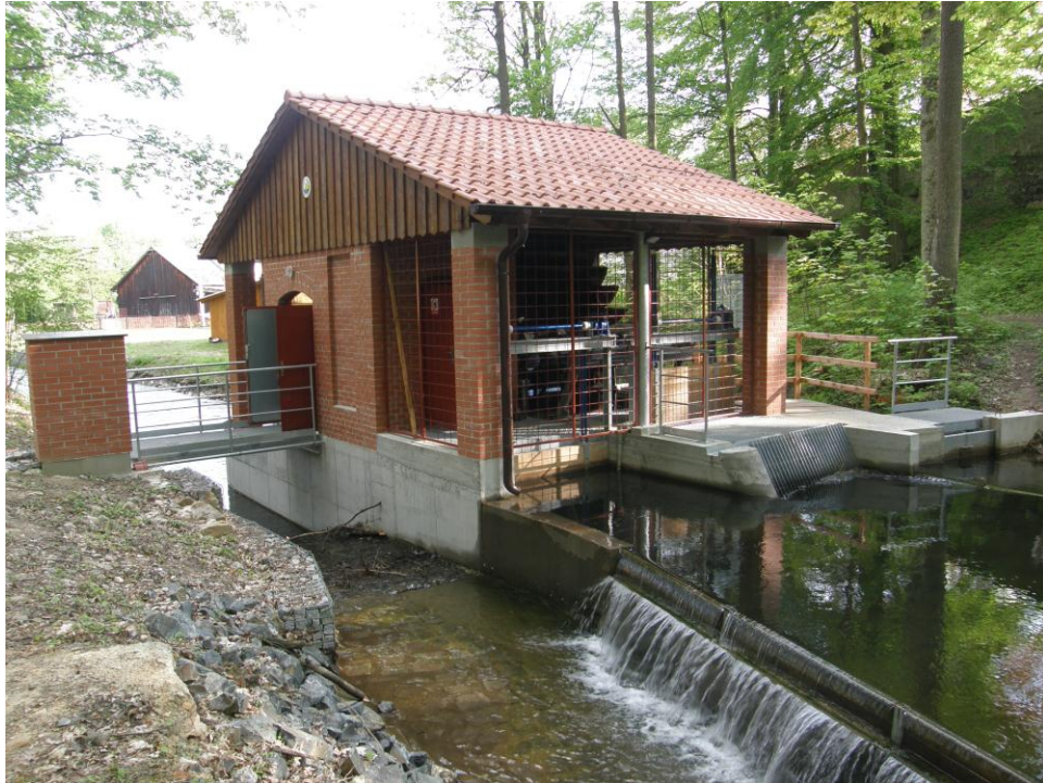
Obr. 1. Budova elektrárny z Jihozápadní strany
