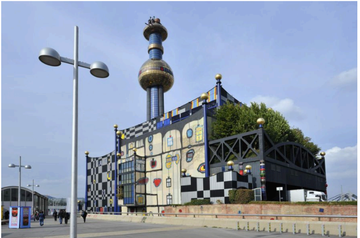
Obr. 2.7: Zařízení pro energetické využití odpadů Spittelau ve Vídni [15]
