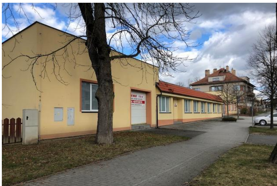
Obr. č. 11: Zrekonstruovaná výrobní hala společnosti Elektra Týn s.r.o. v ulici Tyršova 619 (převzato z [47])
