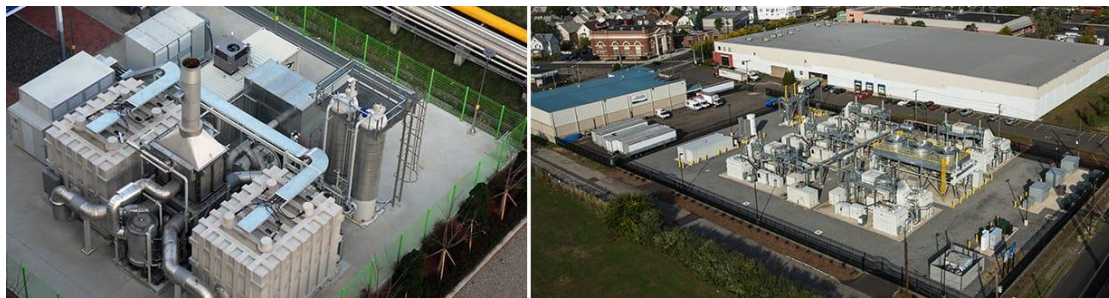
Obr. 11: SureSource 3000 FC systém o instalovaném výkonu 2,8 MW (převzato z [26]).
