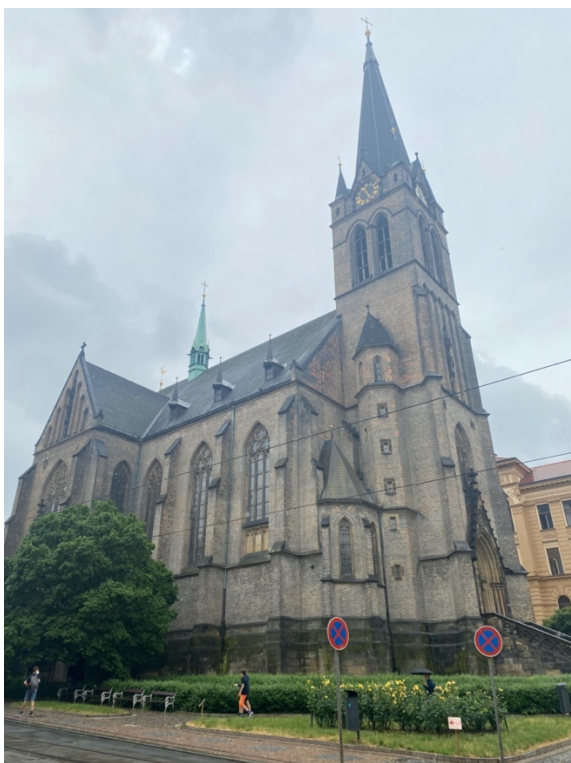
Příloha 22: Kostel sv. Prokopa na Žižkově 186
