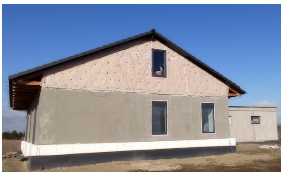
Obr. 13: Stavba moderního RD ve Vochově
