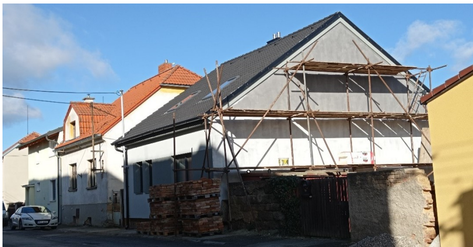
Obr. 20: Opravená starší zástavba mezi neopravenou
