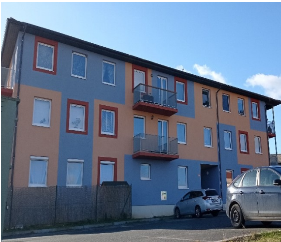
Obr. 19: Opravený BD ve Vochově
