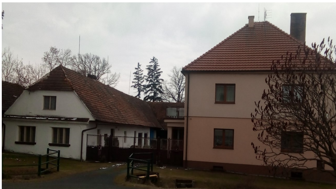
Obr. 54: Opravená starší zástavba mezi neopravenou
