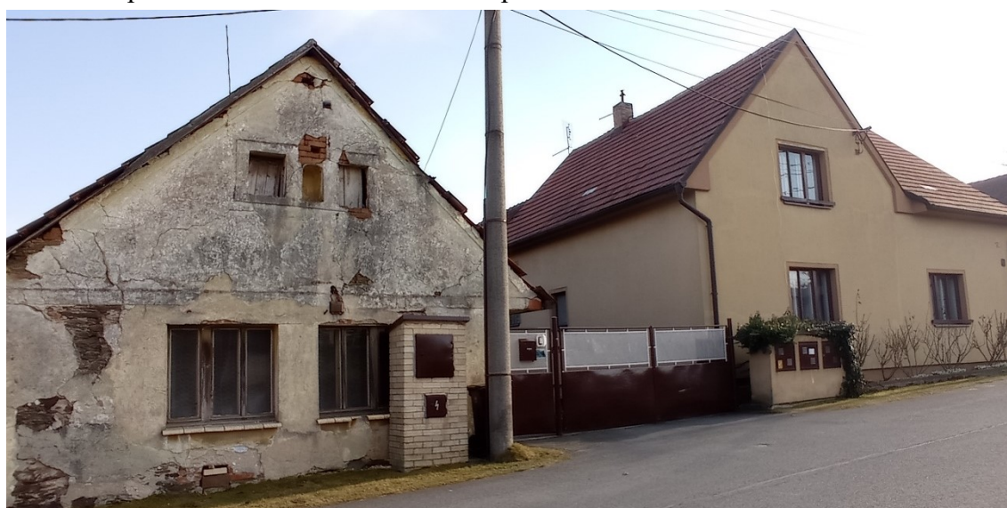
Obr. 39: Opravená starší zástavba mezi neopravenou
