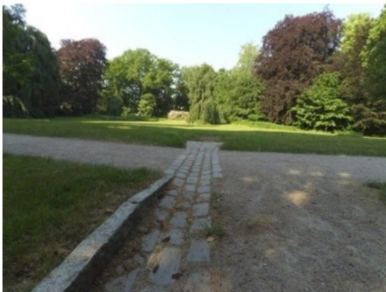
Obr. 11: Průleh sloužící k povrchovému odvodnění
