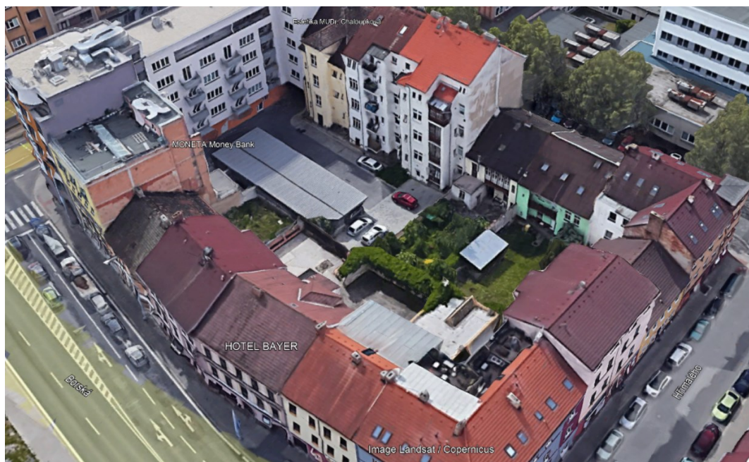
Obrázek 14: 3D snímek vnitrobloku B z roku 2021 (2)
