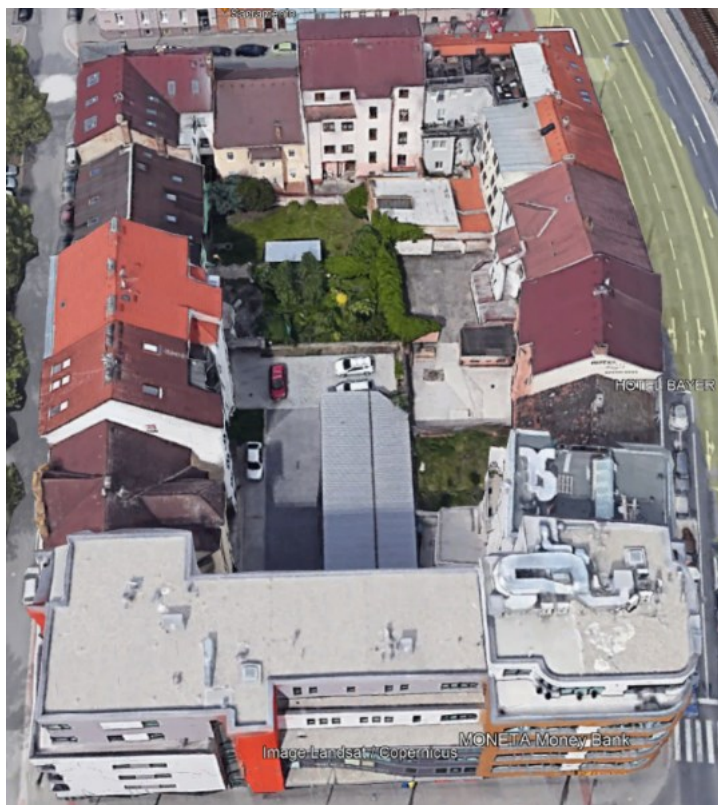
Obrázek 15: 3D snímek vnitrobloku B z roku 2021 (1)
