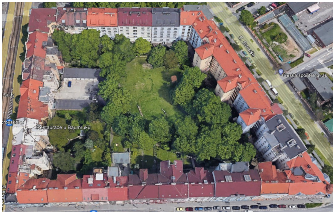
Obrázek 25: 3D snímek vnitrobloku J z roku 2021 (1)
