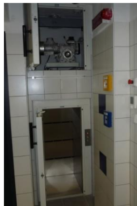
Obrázek 7 - Pohled do šachty výtahu firmy Voto s.r.o. [7]
