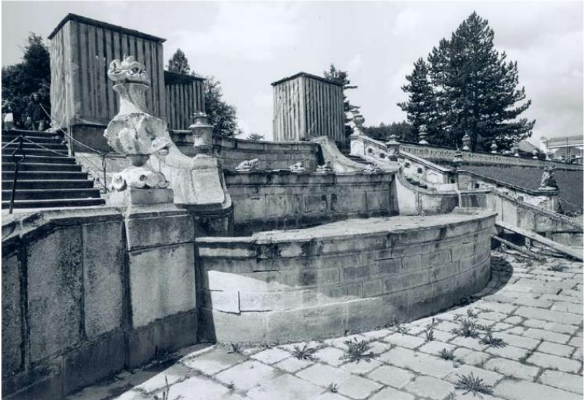
17. Stav kaskádové fontány v roce 1995, sousoší na horním stupni fontány byly chráněny před poškozením dřevěnými kryty.
