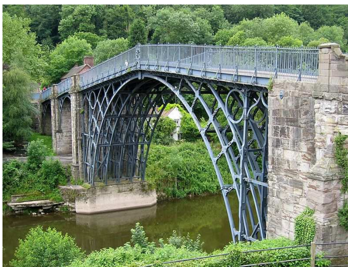
Obr. 2.1: Iron Bridge v Anglii, převzato z [5]
