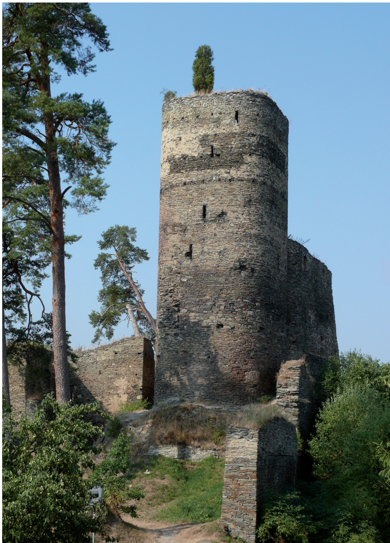
Obr. 1. Pohled na věž od východu. Foto L. Hobl 2015. – Abb. 1. Blick auf den Turm von Osten (Fotografie L. Hobl 2015).
