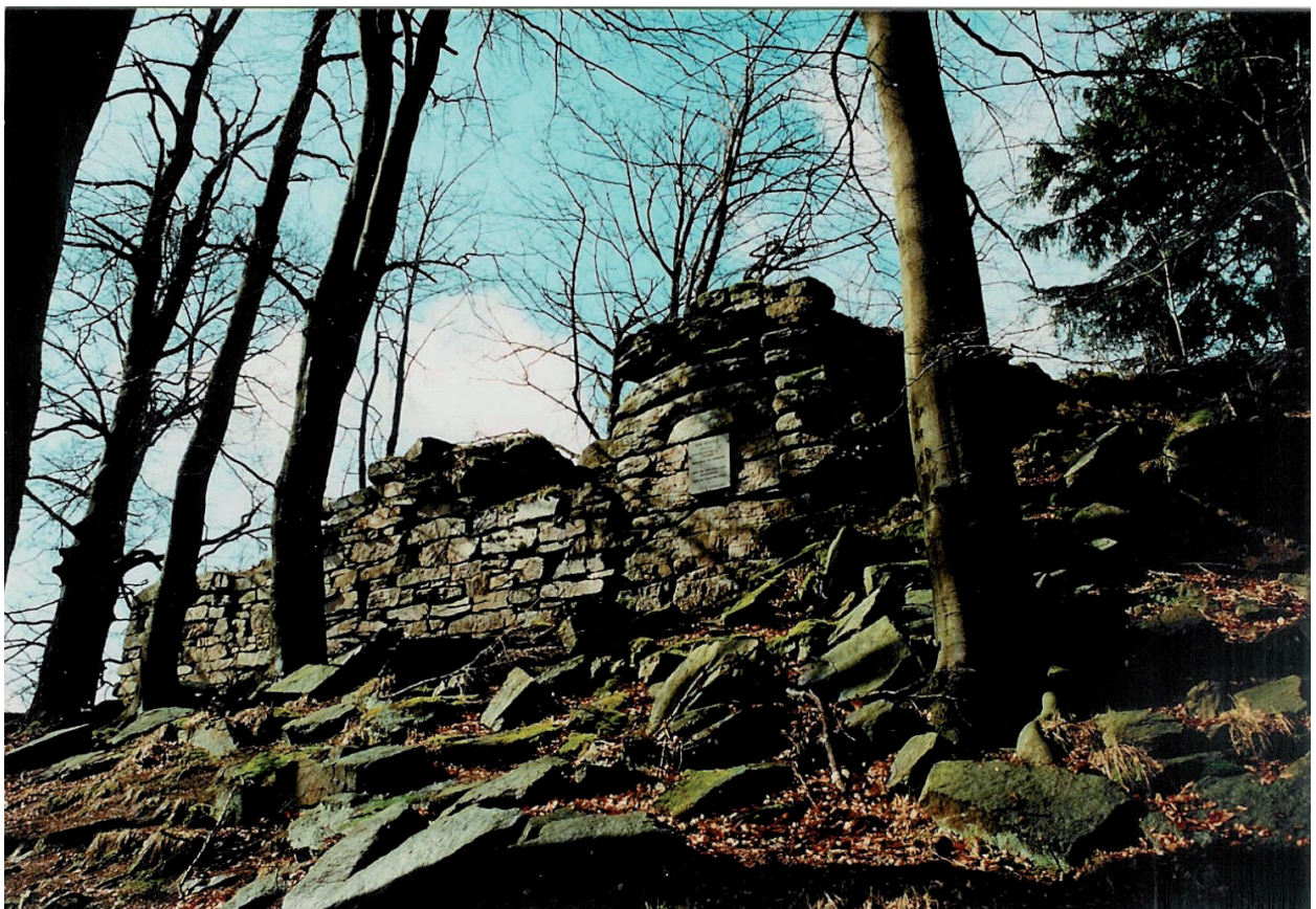
Obr. 10. Hirschstein, pohled od severu na jádro hradu s nejlépe zachovalým pozůstatkem zdiva. Foto V. Keller, 2001. – Abb. 10. Hirschstein, Blick aus nördlicher Richtung auf die Kernburg mit meist erhaltenen Mauerresten. Foto V. Keller, 2001.
