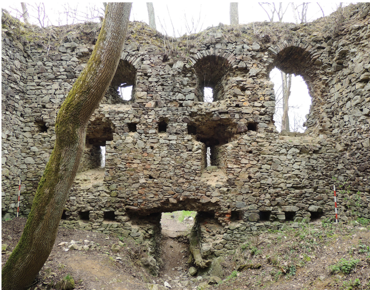
Obr. 21. Nový Herštejn (okr. Domažlice). Pohled na západní zeď interiéru donjonu se stavebním otvorem v úrovni prvního podlaží a původním vstupem v úrovni třetího podlaží. Foto Zlata Gersdorfová 2016. – Abb. 21. Hirschstein / Neu Herrnstein (Bez. Taus). Der Blick auf die westliche Mauer im Innenraum des Donjons mit einer Bauöffnung in der Ebene des ersten Stockwerks und mit dem einstigen Eingang in der Ebene des dritten Stockwerks. Foto Zlata Gersdorfová 2016.
