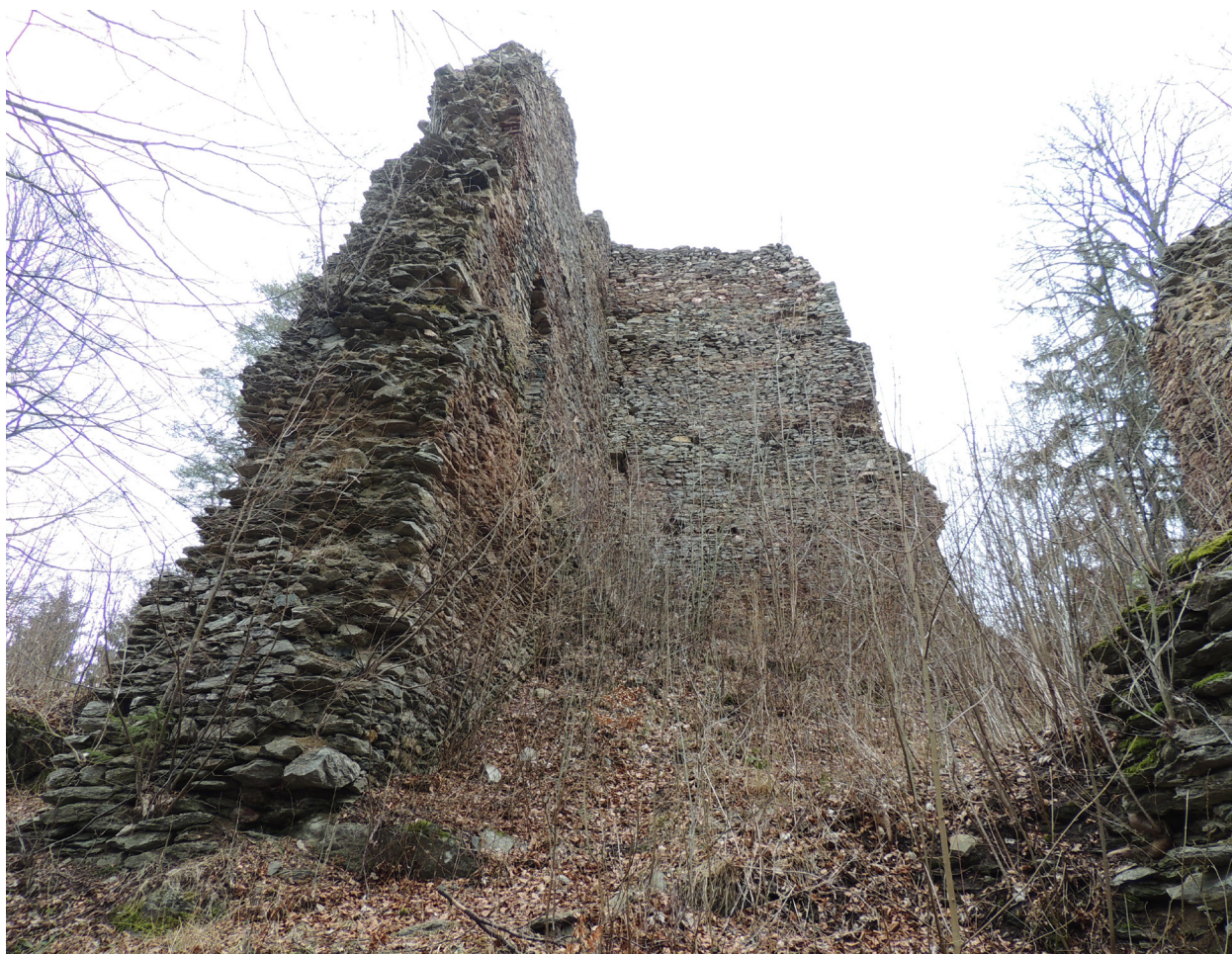
Obr. 16. Pajrek (okr. Klatovy). Pohled do interiéru donjonu od jihu. Foto Zlata Gersdorfová 2016. – Abb. 16. Beyereck (Bez. Klattau). Der Blick in den Innenraum des Donjons vom Süden. Foto Zlata Gersdorfová 2016.
