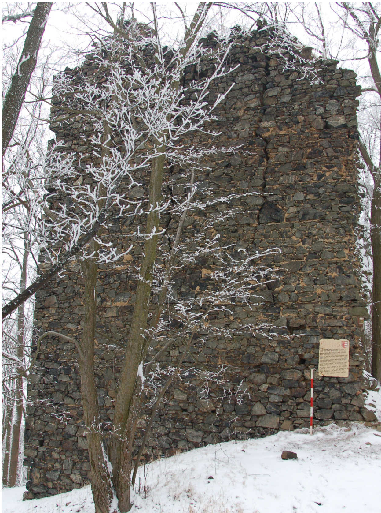
Obr. 8. Netřeb (okr. Domažlice). Relikty vnějšího líce jižní obvodové zdi a jihozápadního nároží donjonu. Foto autor 2017. – Abb. 8. Neu Riesenberg (Bez. Taus). Relikte der südlichen Ringmauer und der südwestlichen Ecke des Donjons. Foto Autor 2017.
