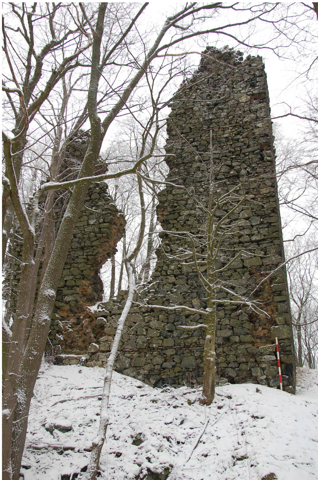
Obr. 10. Netřeb (okr. Domažlice). Relikty vnějšího líce západní obvodové zdi donjonu a jihozápadního nároží. Foto autor 2017. – Abb. 10. Neu Riesenberg (Bez. Taus). Relikte der westlichen Außenmauer des Donjons und der südwestlichen Ecke. Foto Autor.
