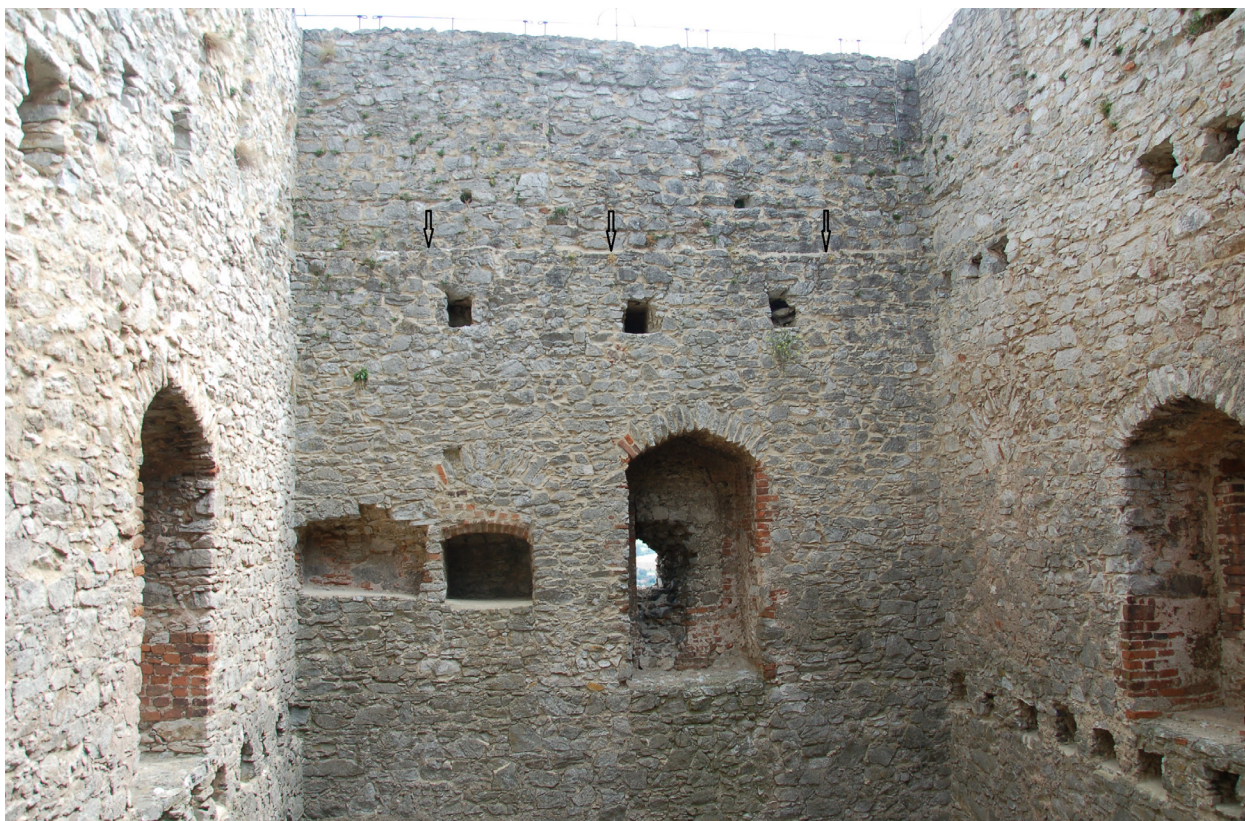
Obr. 26. Hrad Rabí (okr. Klatovy). Odsazení obvodového zdiva (označeno šipkami) pátého podlaží v interiéru donjonu. Foto a úprava autor 2018. – Abb. 26. Rabí (Bez. Klattau). Der Absatz der Ringmauer (mit einem Pfeil markiert) im fünften Stockwerk des Donjons. Foto und Bearbeitung Autor 2018.
