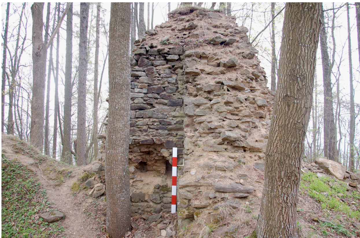
Obr. 6. Pušperk (okr. Klatovy). Jihovýchodní roh interiéru donjonu s dochovanými otvory po stropních trámech prvního podlaží s viditelným odsazením (označeno čarou) obvodového zdiva. Foto a úprava autor 2014. – Abb. 6. Puschberg / Fuchsberg (Bez. Klattau). Die südwestliche Ecke des Donjon-Innenraumes mit den erhaltenen Deckenbalkenlöchern des ersten Stockwerkes mit dem sichtbaren Absatz des Umfassungsmauerwerks. Foto und Bearbeitung Autor 2014.
