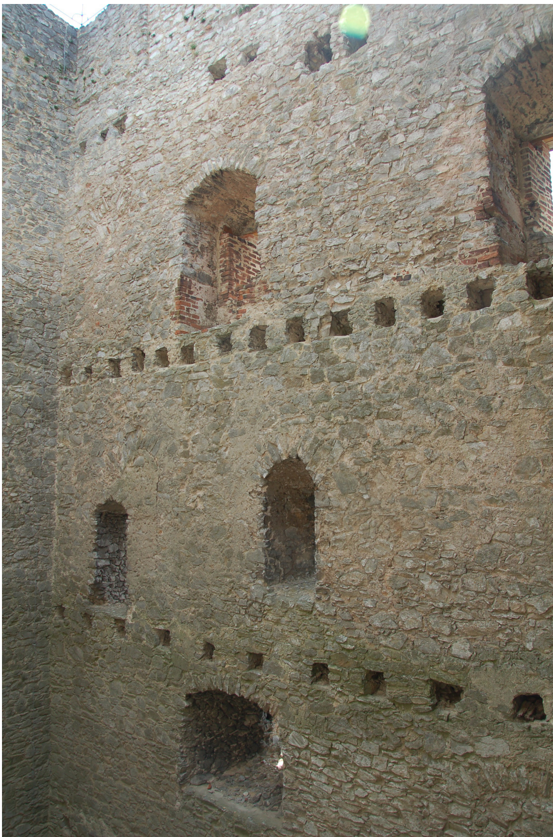
Obr. 27. Hrad Rabí (okr. Klatovy). Pohled na severovýchodní stěnu interiéru donjonu s otvory po instalaci stropních trámů v jednotlivých podlažích. Foto autor 2017. – Abb. 27. Rabi (Bez. Klattau). Der Blick auf die nordöstliche Mauer des Donjon-Innenraums mit den Deckenbalkenlöchern in den einzelnen Stockwerken. Foto Autor 2017.
