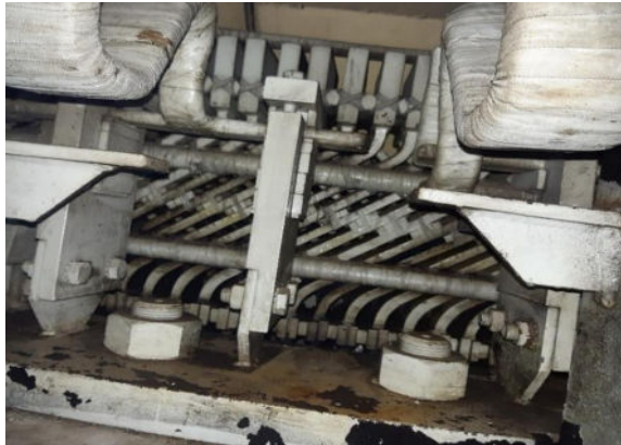
Obr. 3a: Pohled na čela spodní polohy statorového vinutí v horní části generátoru
