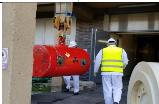
Obr. 5: Transport kontejneru TKS-1000 na měřicí pracoviště
