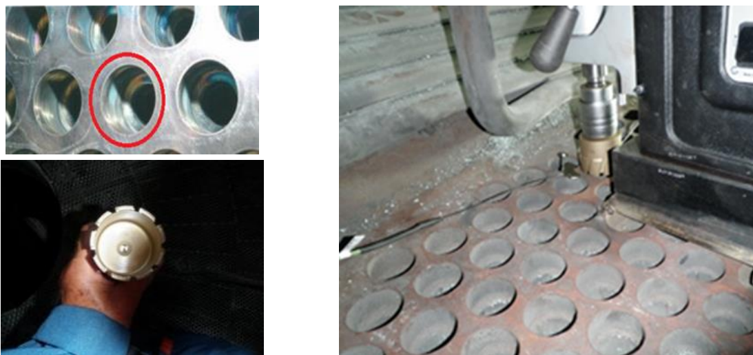
Obr. 4: Vyznačená plocha vývrty, použitý vrták a místo vývrty osazené termočlánky
