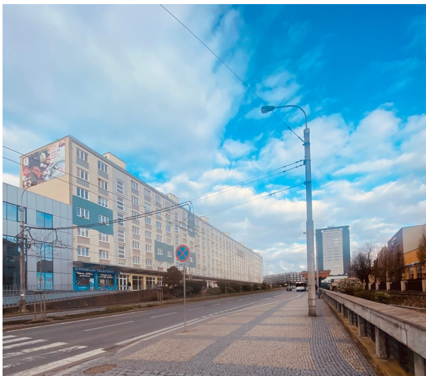
Obr. 2: Dnešní pohled na ulici Palackého
