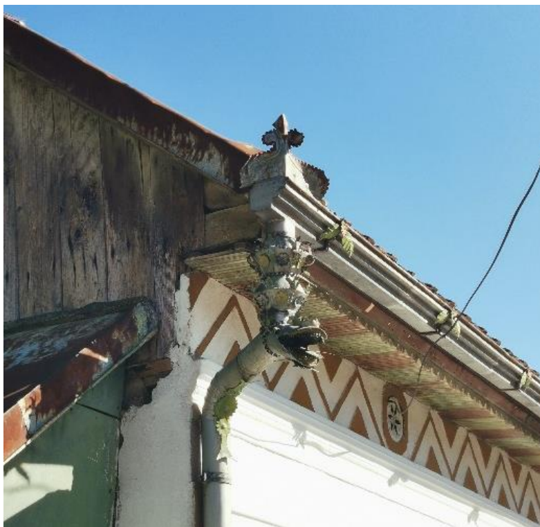
Obr. 18: Zdobení okapní svod domu na Gerníku
