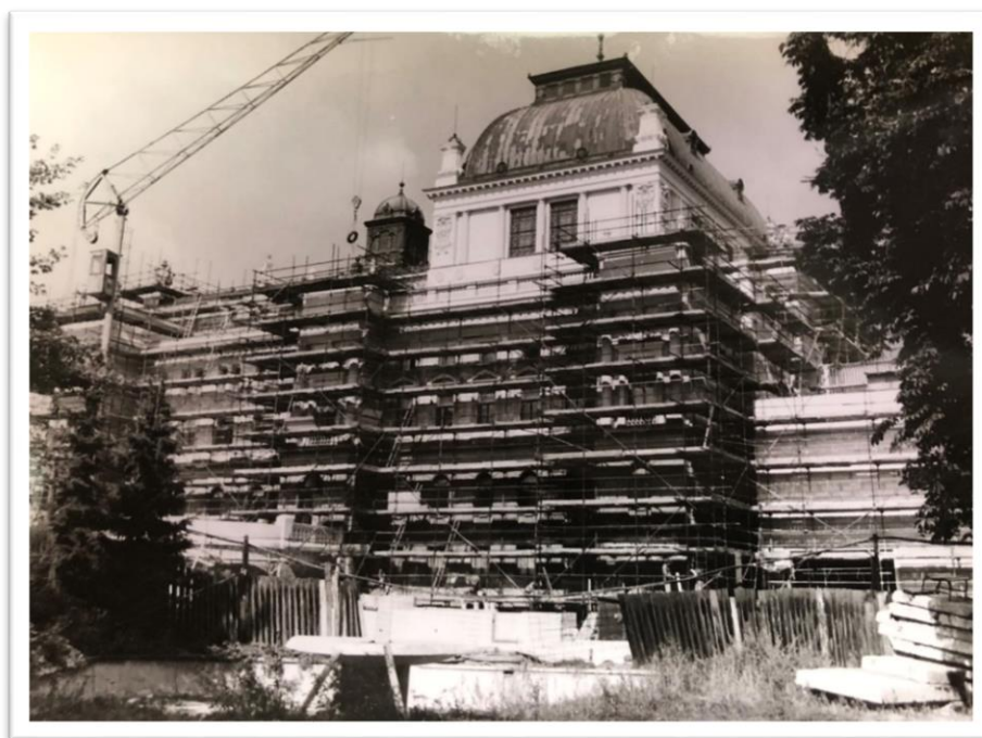
Obrázek č. 25: Renovace omítky budovy
