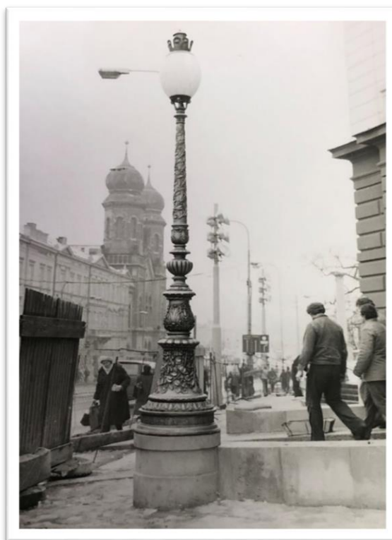
Obrázek č. 26: Osvětlovací pylony po rekonstrukci
