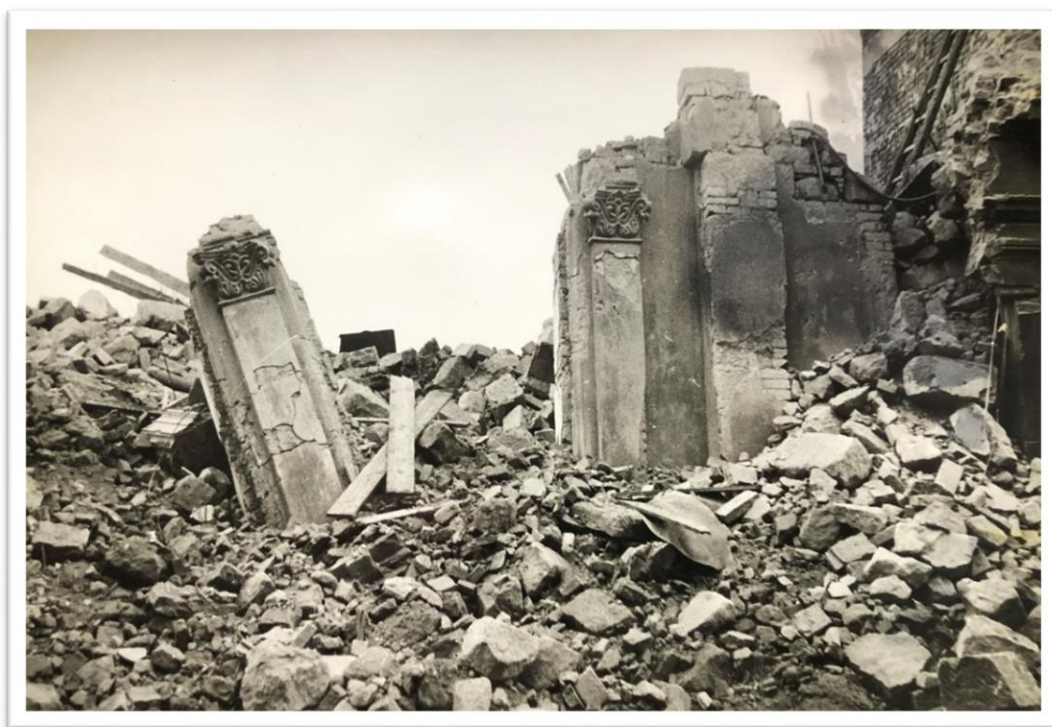
Obrázek č. 19: Demolice divadla v Riegrově ulici
