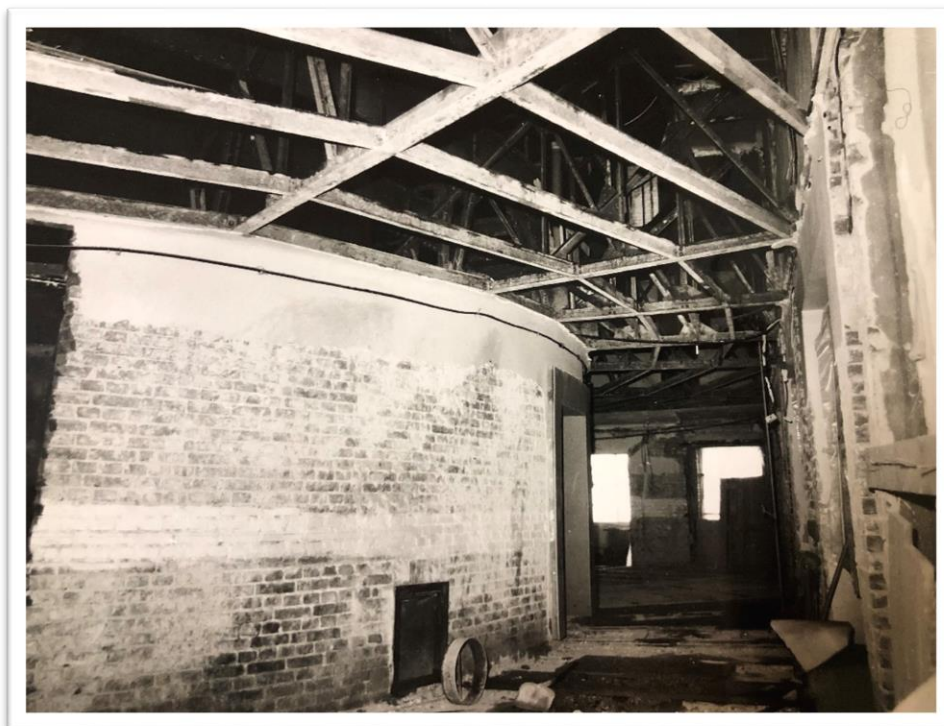
Obrázek č. 22: Rekonstrukce – bourací práce
