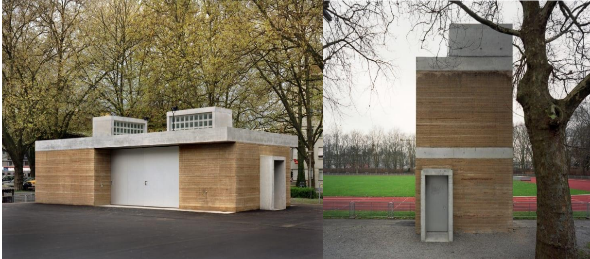
Obrázok 4 Exteriér prevádzkových budov športového centra od Boltshauser Architekten (Boltshauser Architekten 2017)
