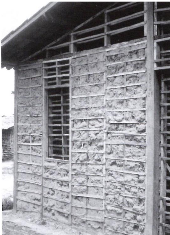
Obrázok 12 Prefabrikované drevené prvky skeletu vyplnené hlinou, Brazília (Minke 2009, s. 127)
