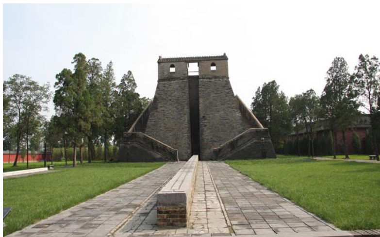
Obrázek 42 Císařská observatoř u Ten-fengu. Před pozorovací pyramidou se táhne měřítko, na kterém byly odpočítávána data za pomoci stínu vrhaného gnómonem (Fengxian 2010, 92, 5.2.1)
