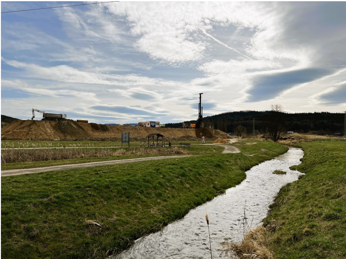
Obr. 8: Přeložka silnice I/27 u městské čtvrti Luby
