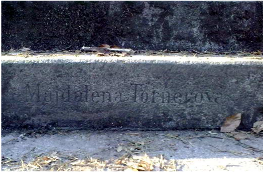
Příloha č. 18: Schod se jménem Magdalény Tornerové na cestě ke kostelu Navštívení Panny Marie na „Vršíčku“ v blízkosti Rokycan. Peníze na stavbu kostela byly získány veřejnou sbírkou, stejně jako prostředky na vybudování těchto schodů, kam byla vytesána jména donátorů.
