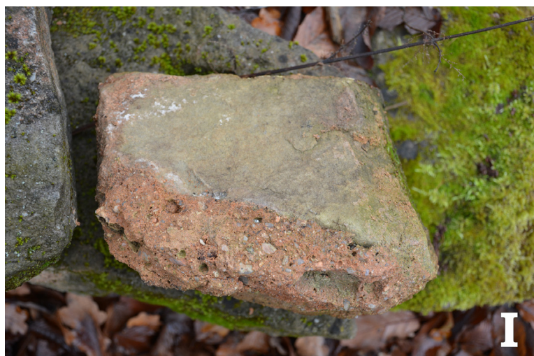
Obr. 6. G) pohled na vnější líc obvodové zdi jádra hradu v jeho východní části, H) pohled na vnitřní líc zdiva přístavby vysunutě do příkopu. I) doklad využití malty při zdění obvodové hradby jádra hradu (foto P. Drnovský, 2022). – Fig. 6. G) view of the outer side of the castle core's defensive wall in its eastern part, H) view of the inner face of the masonry of the extension projecting towards the ditch. I) evidence of the use of mortar in the construction of the defensive wall of the castle core (photos P. Drnovský, 2022).
