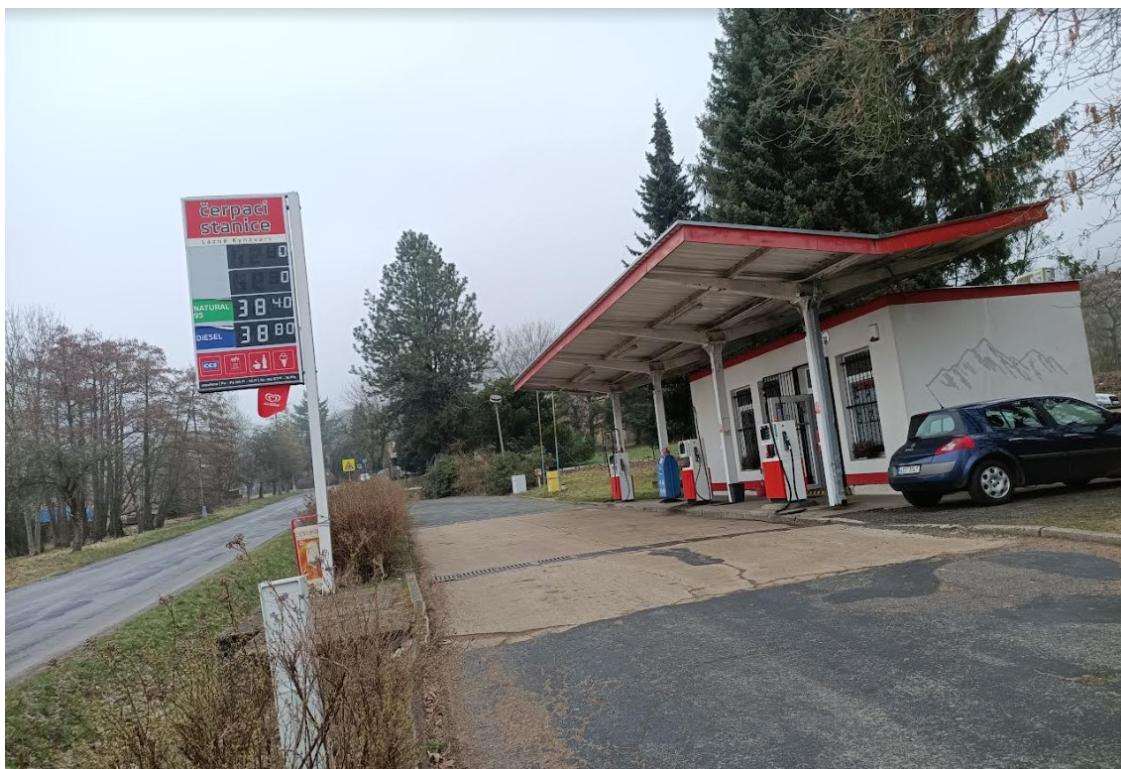
Obrázek 8: Čerpací stanice v Lázních Kynžvart
